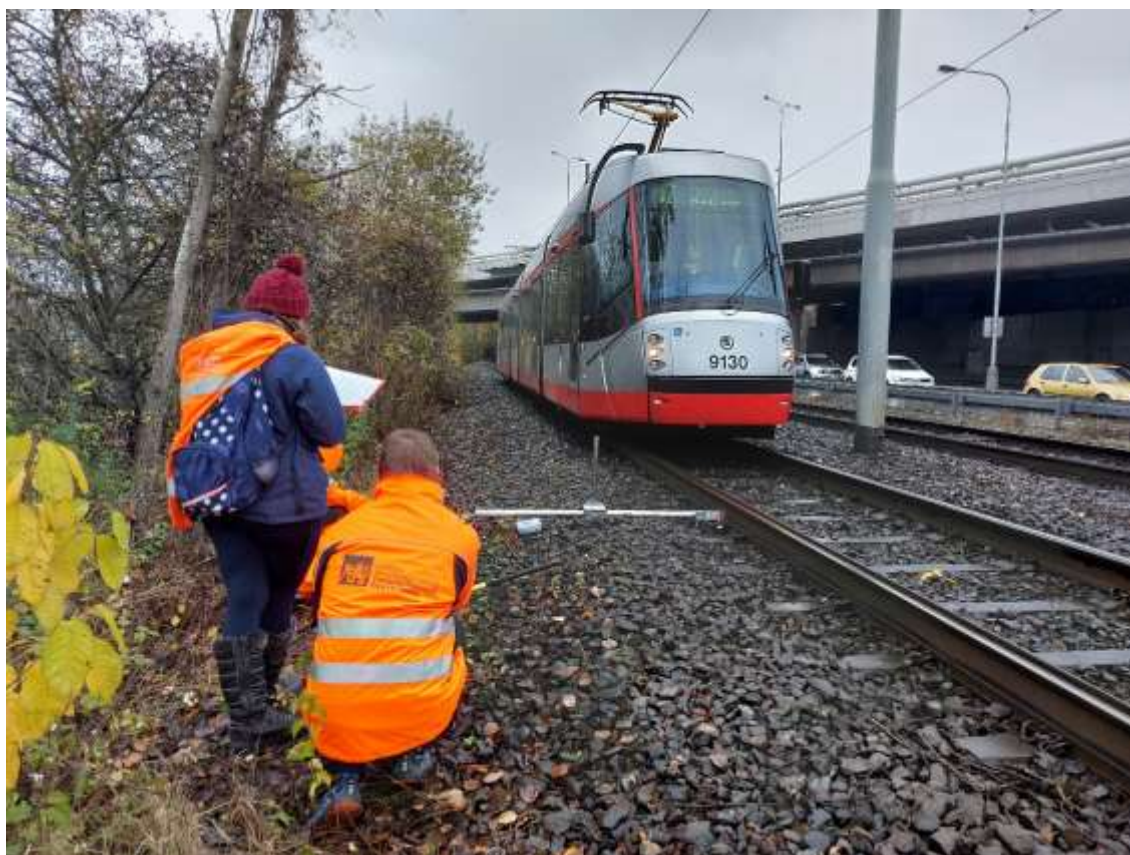
Obr. 18: Měření v Braníku [Zdroj: Autor]
