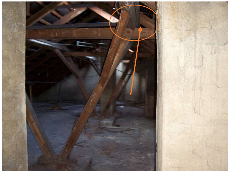
Obrázek 1 - Souběh krokve, kleštiny a vaznice
