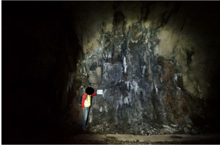
Obr. 13 Polubenský tunel – ostenie zo striekaného betónu bez výztuže [11]
