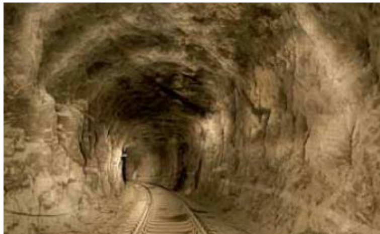
Obr. 6 Jarovský tunel - pohľad na výrub bez zaistenia ostením [4]
