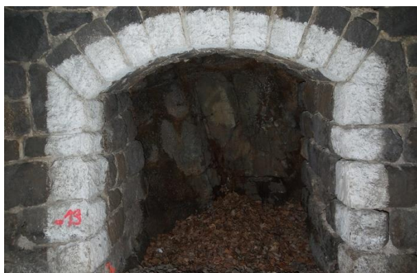
Obr. 28 Pohľad na obnaženú horninu – záchranný výklenok [20]
