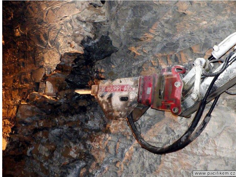
Obr. 8 Jarovský tunel - búracie práce [7]
