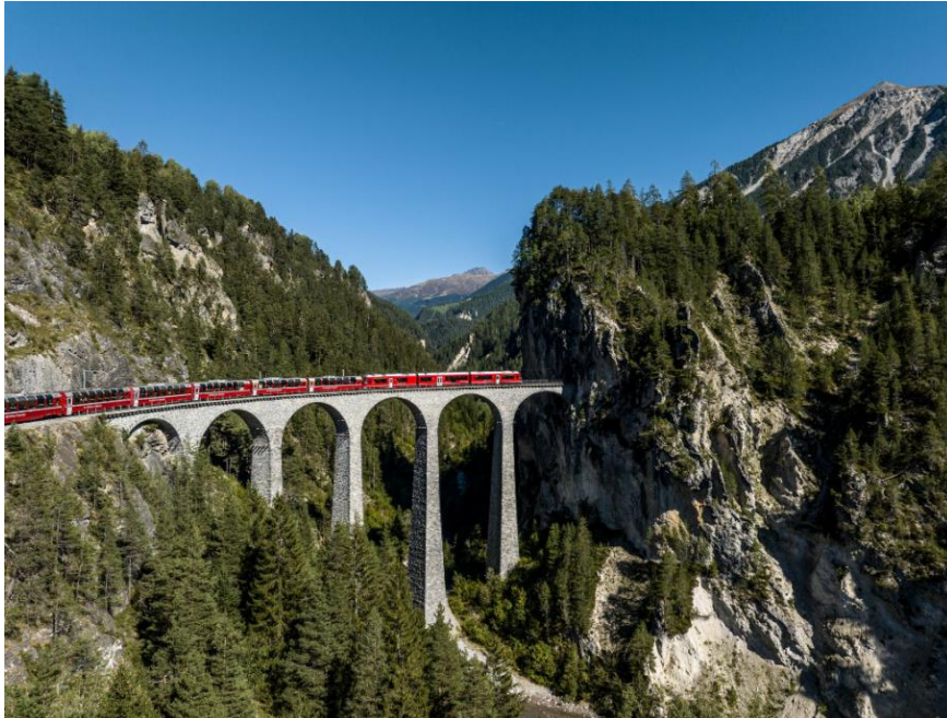
Obr. 17 Tunely RhB – Viadukt Landwaser s nadväzujúcim tunelom Landwasser [13]
