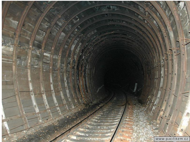
Obr. 5 Jarovský tunel - pohľad na provízórne vystrojenie portálových úsekov [6]
