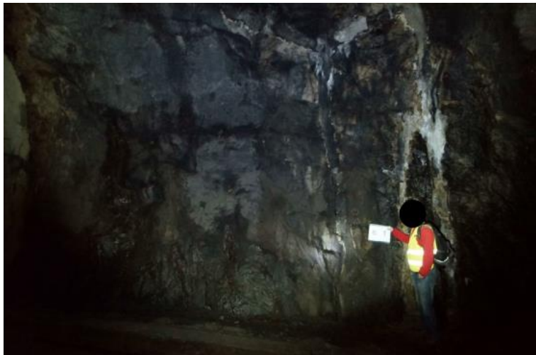
Obr. 14 Polubenský tunel – úsek bez ostenia so zvodnicou [11]
