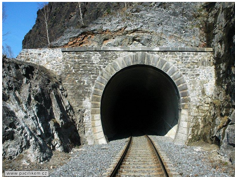
Obr. 9 Jarovský tunel - pohľad na vranovský portál po rekonštrukcii (2008) [8]
