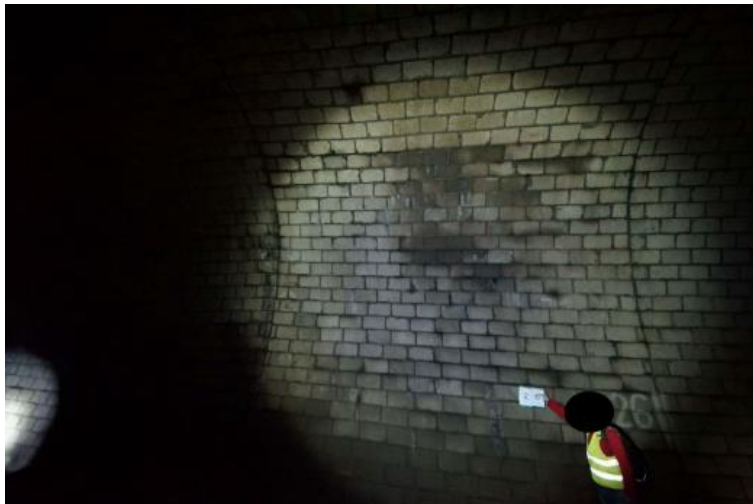
Obr. 11 Polubenský tunel – zavodenie opory ostenia z betónových tvárnic [11]
