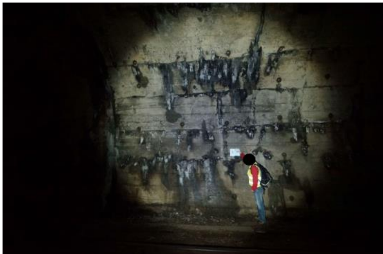
Obr. 12 Polubenský tunel –ostenie z prepakt betónu [11]
