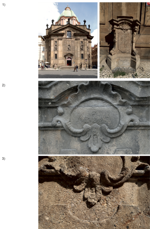
Obr. 1 Kostel sv. Františka z Assisi, Křížovnické náměstí, Praha (1), kamenný podstavec s detailem opracování povrchu před (2) a po (3) restaurátorském zásahu. Restaurovaný vykazuje jasné stopy ztráty materiálu a abraze.
