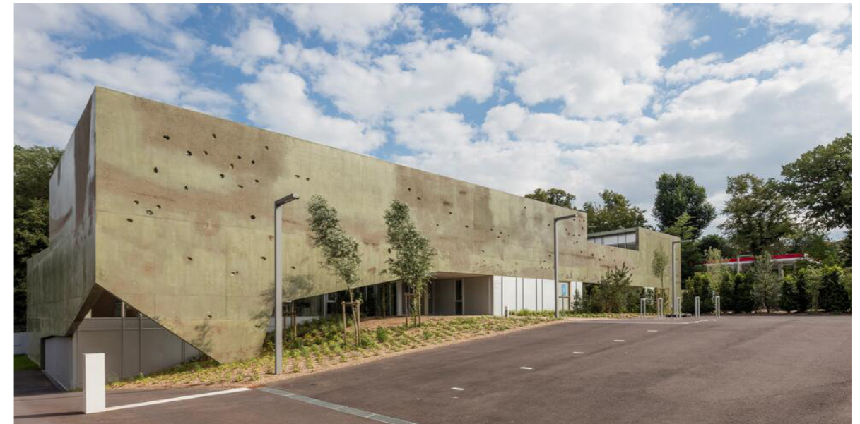
△ Obr. 16 Budova centra pro psychiatrickou péči pro děti a dospělé ve francouzském Metz [23] Architektonická kancelář Richter Architectes našla v proměně barevnosti vlivem obnažení zrn kameniva pozitivum a ztvárnila tak výrazový prvek budovy centra pro psychiatrickou péči pro děti a dospělé, která má působit jakoby vycházela ze země. Exponaci zrn kameniva bylo dosaženo vysokotlakým čističem, který tlakem vody porušil vrchní pohledovou vrstvu a obnažil použitý agregát [22].
