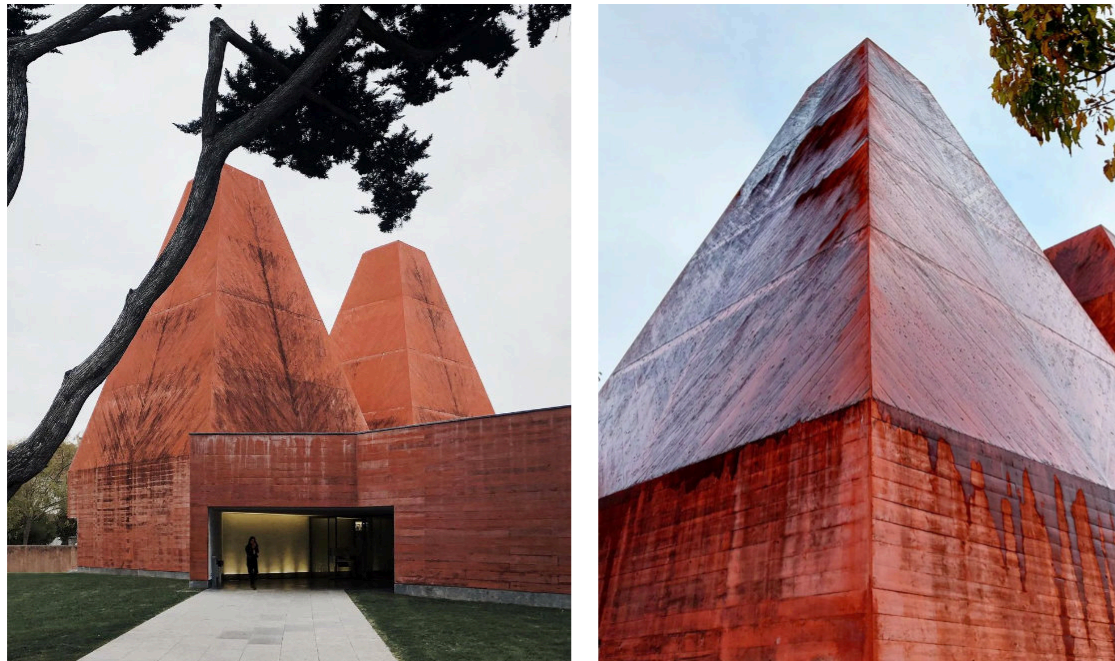
△ Obr. 14 Propisující se trvalá proměna pohledových ploch červeně probarveného betonu Muzea umění Pauly Rego vlivem dešťových srážek [21] Budova muzea je probarvena z červeně probarveného betonu se specifickou vizuální strukturou použitého bednění. Dlouhodobé účinky dešťových srážek vytvářejí na fasádě dojem prokresleného stromu
