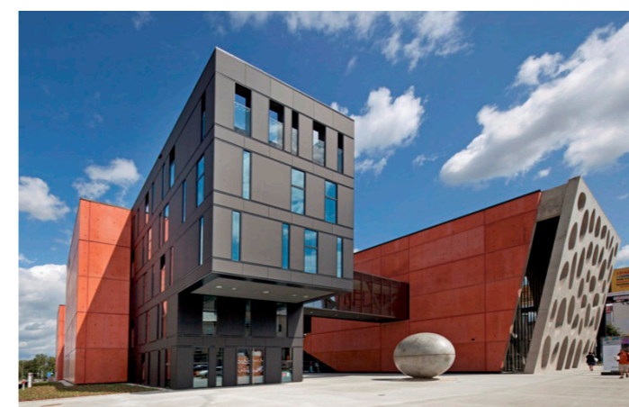
◀ Obr. 27 Pohled na průčelí divadla [99]
