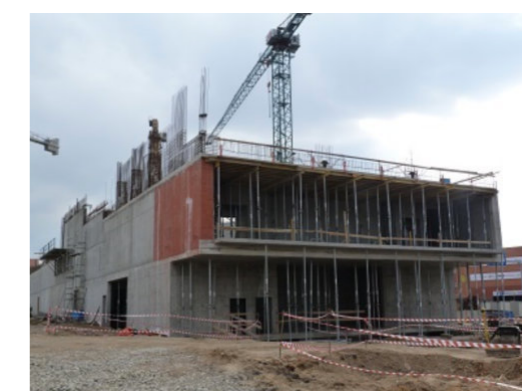
▽ Obr. 29 Průběh výstavby a a betonáže [100,101]
