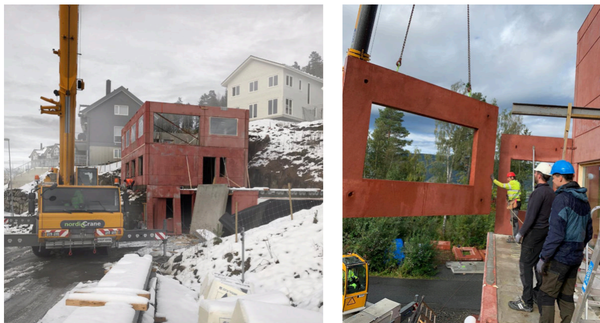
▽ Obr.21 Průběh výstavby [61]
