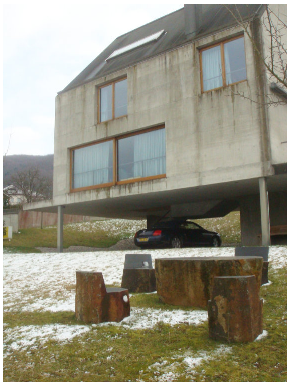
◁ Obr. 19 Rudin House, Leymen, propisující se trvalá proměna pohledových ploch vlivem absence okapnice [19]
