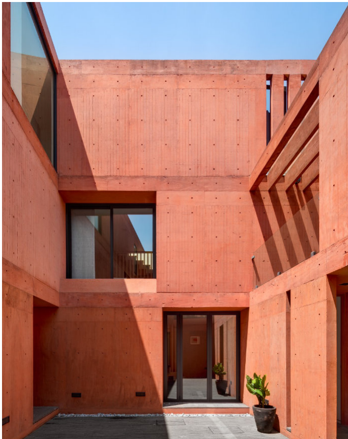
◁ Obr. 87 Rezidence v Mexiku. Dvě různé textury v červeně pigmentovaného betonu odlišují úrovně a jednotlivé funkce domu ARCHITEKT: Estudio MMX [85]
