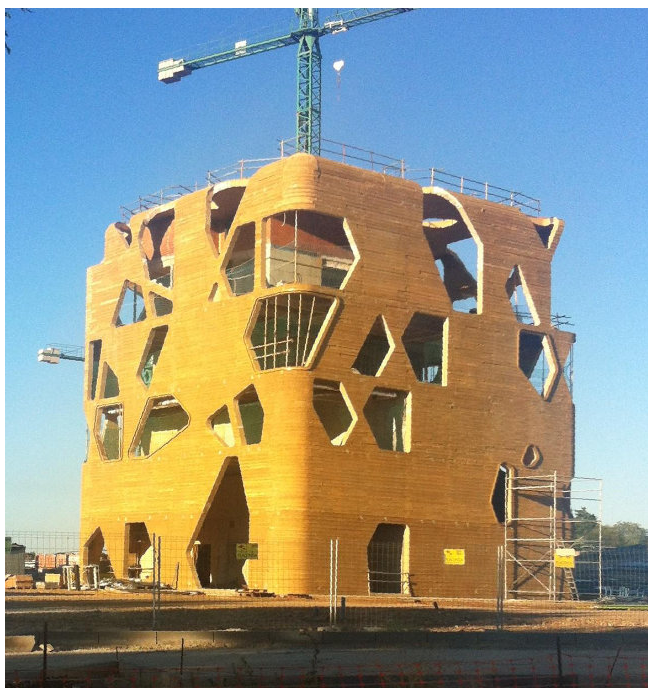
▽ Obr.60 Průběh výstavby [50,54,55]
