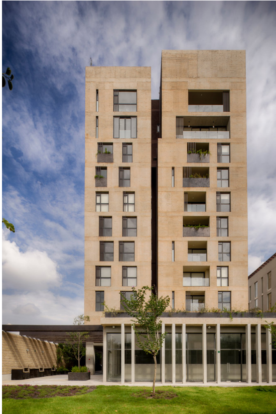
◁ Obr. 93 Bytový dům v Mexiku. Betonová fasáda probarvena do pískového odstínu ARCHITEKT: Anonimus [91]
