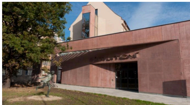
▽ Obr. 101 Vstupní trakt do Domu umění po rekonstrukci [95]
