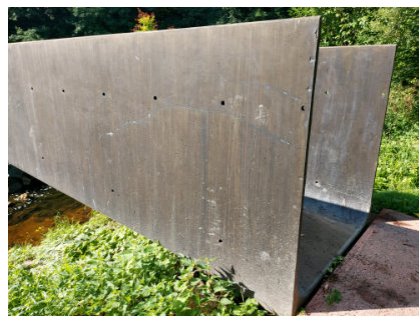
◁ Obr. 111 Prefabrikovaná lávka přes Dřetovický potok ve Vrapicích u Kladna z černě probarveného vysokopevnostního betonu s rozptýlenou výztuží Realizace: 2019 ARCHITEKT: AOC architekti
