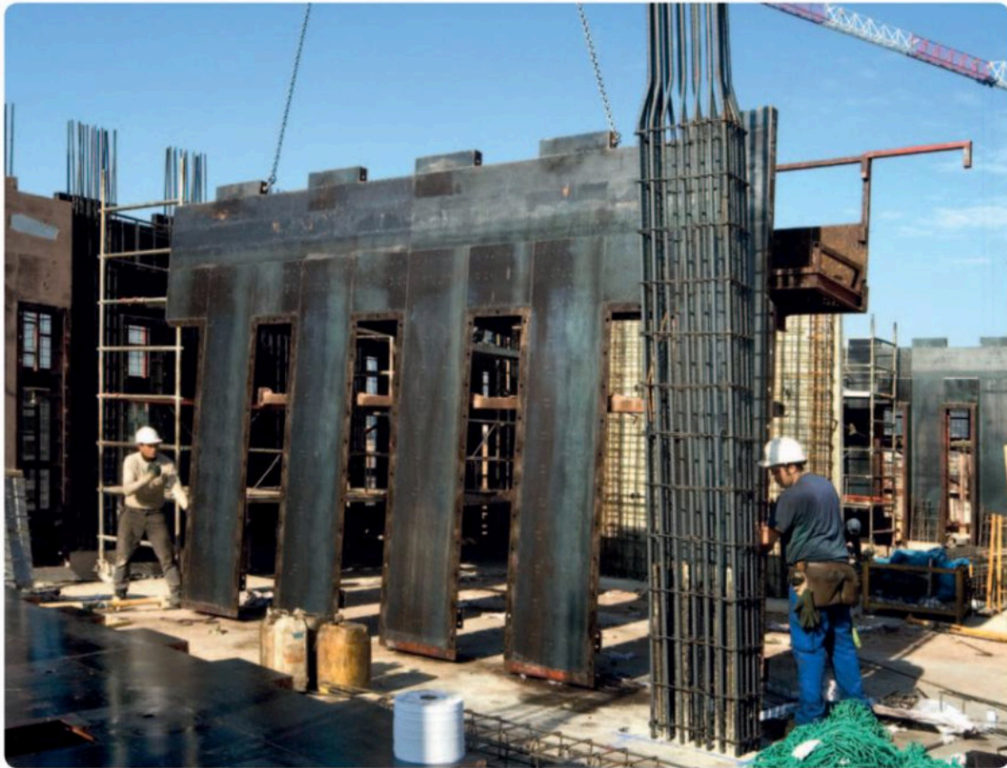
▽ Obr. 49 Průběh bednění [5]
