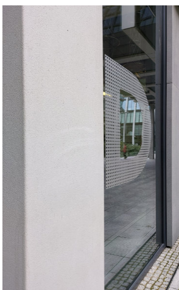
◁ Obr. 115 Státní okresní archiv Louny. Fasádní obkladové panely z bílého betonu v tloušťce 10 cm. V provedení hladké prefabrikované panely a panely s vloženou maticí Realizace: 2021 PROJEKTANT: SATER - PROJEKT, s.r.o. [107]
