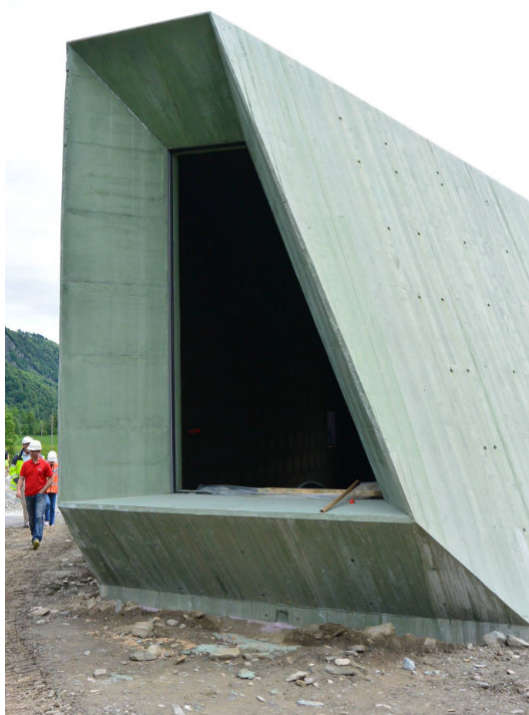
◁ Obr. 32 Část betonové konstrukce po odbednění [34]
