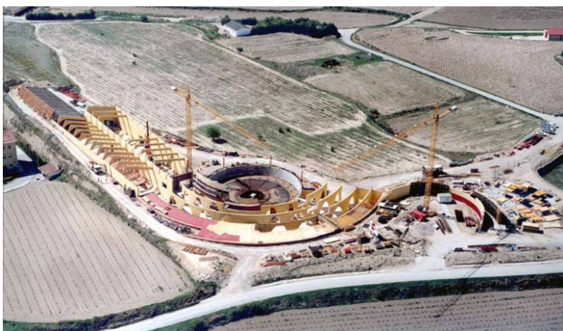
◁ Obr. 56 Průběh výstavby [47,49] ▽
