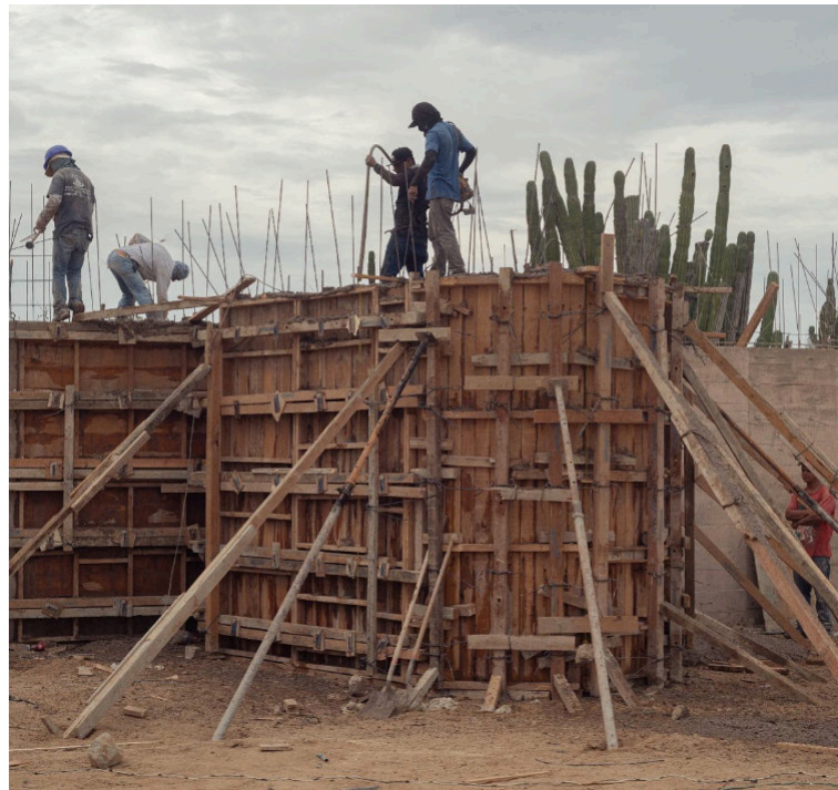
▽ Obr. 44 Proces odlevání betonové směsi do bednění z hrubých dřevěných prken, které po vytvrzení betonu a odbednění zanechají viditelnou texturu [41]
