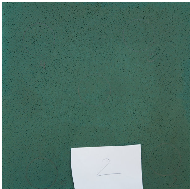
▽ Obr. 117 Fotodokumentace povrchu betonové desky s použitím šedého cementu a přidáním zeleného pigmentu oxidu železa po odbednění
