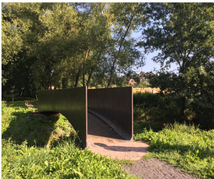
◁ Obr. 111 Prefabrikovaná lávka přes Dřetovický potok ve Vrapicích u Kladna z černě probarveného vysokopevnostního betonu s rozptýlenou výztuží Realizace: 2019 ARCHITEKT: AOC architekti
