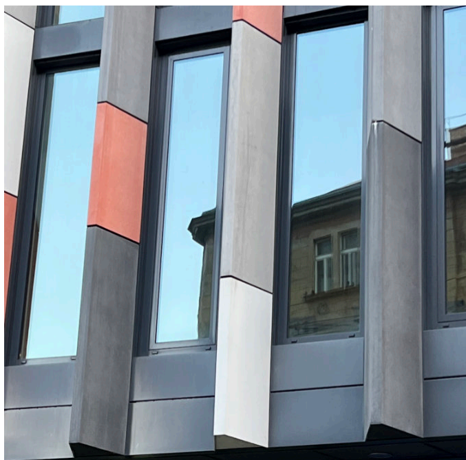
△ Obr. 13 Projevy vápenných výkvětů a bílých výluhů se staly předmětem sporů a reklamací fasádních panelů na budově Main Point v pražském Karlíně. V důsledku nespokojenosti s estetickým vnímáním byla řada panelů vyměněna
