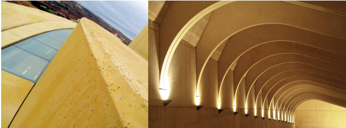
△ Obr. 57 Detaily žlutě probarvených betonových ploch v interiéru a exteriéru [48]
