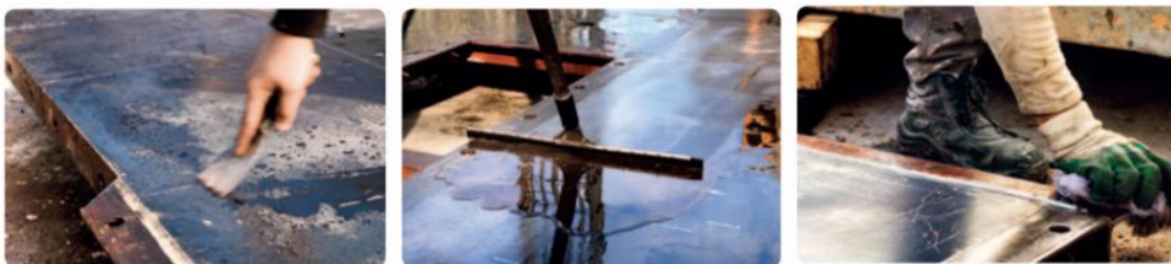
▽ Obr. 50 Ochrana přední strany forem antikoročním nátěrem [5]
