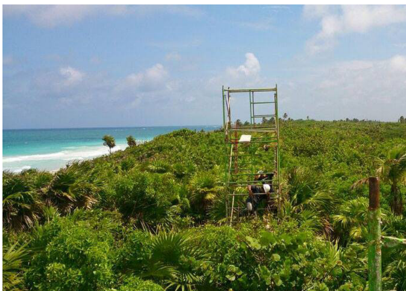
▽ Obr. 40 Konstrukce lešení v budoucím místě výstavby pro definování výšek jednotlivých podlaží a výhledů do krajiny [37]
