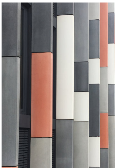
◁ Obr. 113 Main Point Karlín. Charakteristický prvek fasády představují 3D tvarovky ze sklocementu v pěti barevných odstínech Realizace: 2011 ARCHITEKT: DAM Architekti
