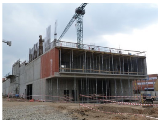
▽ Obr. 104 Průběh výstavby a a betonáže [100,101]
