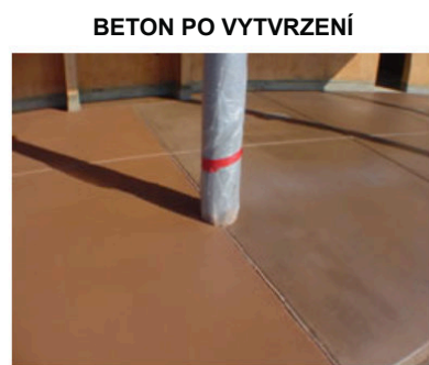
△ Obr. 8 Vliv šarže šedého cementu na výslednou barevnost [9]
