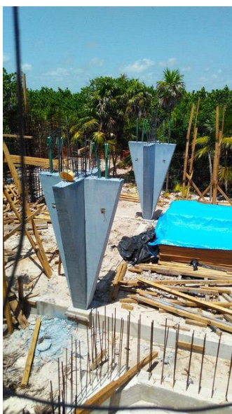
▽ Obr. 39 Betonáž sloupů IN SITU [37]
