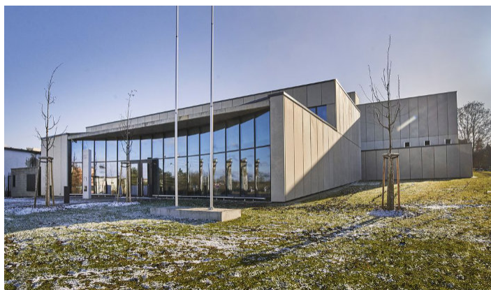
◁ Obr. 115 Státní okresní archiv Louny. Fasádní obkladové panely z bílého betonu v tloušťce 10 cm. V provedení hladké prefabrikované panely a panely s vloženou maticí Realizace: 2021 PROJEKTANT: SATER - PROJEKT, s.r.o. [107]
