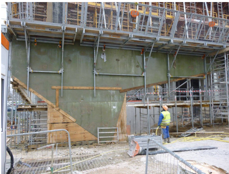
▽ Obr. 30 Práce na staveništi. Betonáž konstrukce ze zeleně probarveného betonu. Perforace betonové hmoty je výsledkem umístění minerální vlny, která byla integrována přímo do bednění. Zdánlivé nedokonalosti jsou ve skutečnosti výsledkem uměleckého procesu [32]
