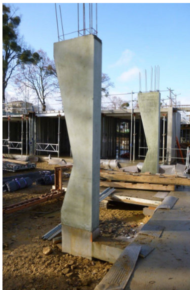
▽ Obr. 30 Práce na staveništi. Betonáž konstrukce ze zeleně probarveného betonu. Perforace betonové hmoty je výsledkem umístění minerální vlny, která byla integrována přímo do bednění. Zdánlivé nedokonalosti jsou ve skutečnosti výsledkem uměleckého procesu [32]
