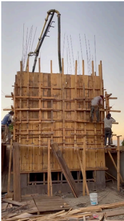
▽ Obr. 44 Proces odlevání betonové směsi do bednění z hrubých dřevěných prken, které po vytvrzení betonu a odbednění zanechají viditelnou texturu [41]
