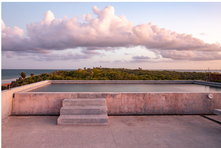
◁ Obr. 37 Pohled zachycující proměnu barvy betonového bazénu na střešní terase při západu slunce [36]
