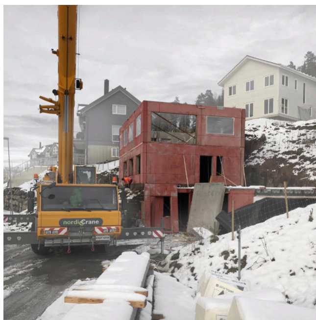
▽ Obr. 70 Průběh výstavby [61]
