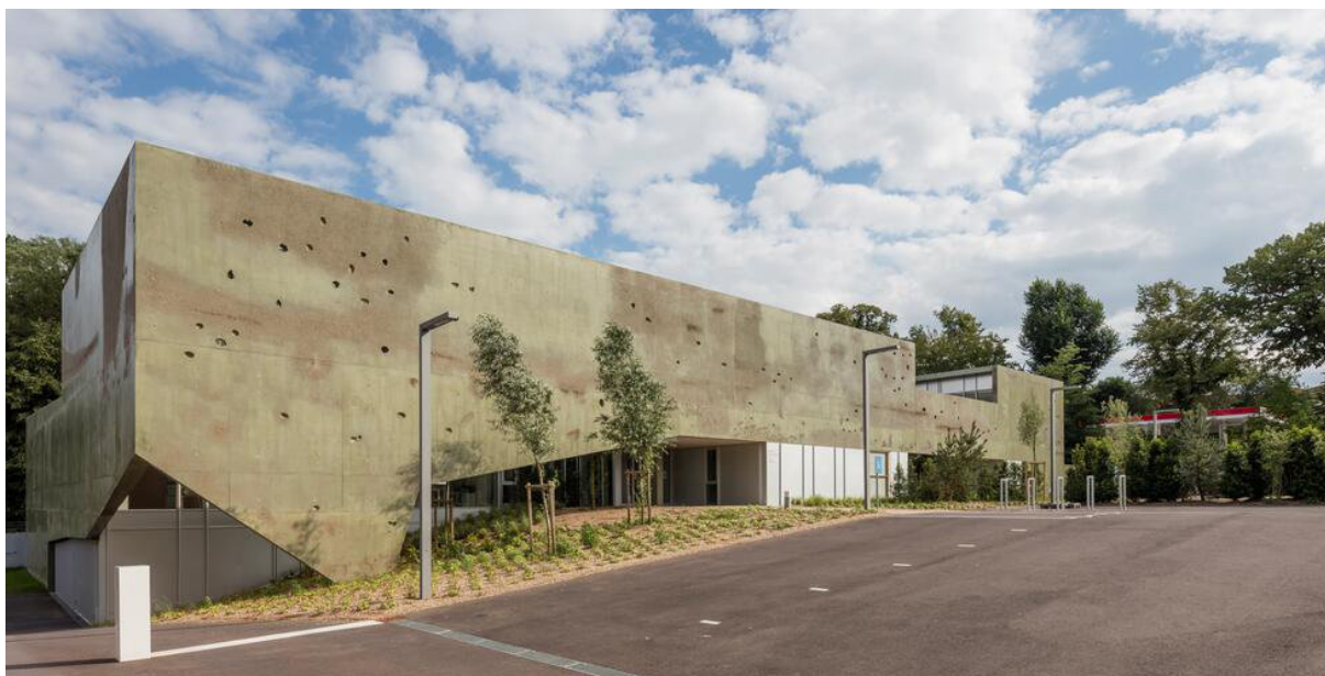
△ Obr. 22 Budova centra pro psychiatrickou péči pro děti a dospělé ve francouzském Metz [23]
