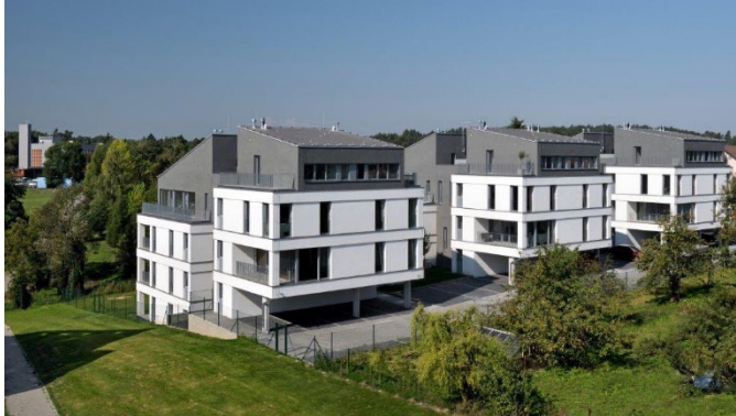
Figure 4.15 Villa Houses Krásnopolská (source: Roman Polášek, archiweb.cz)
