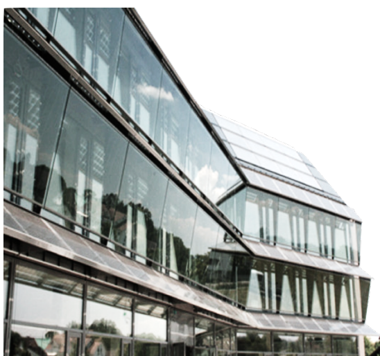
Obr 40 FVE PŘEDSAZENÁ DVOJITÁ FASÁDA – ESSLINGER DREIECK GHC
