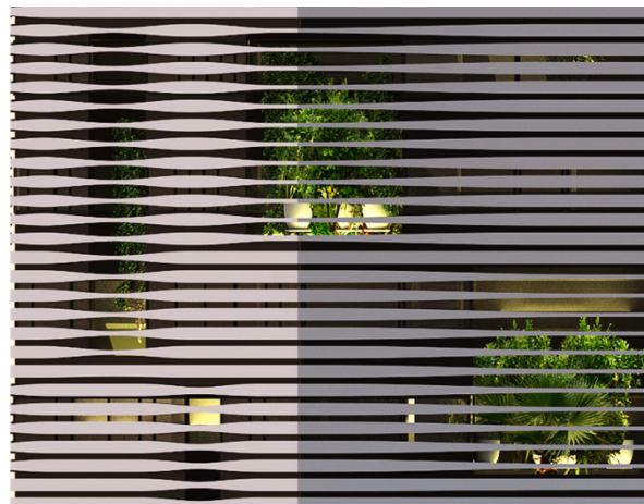
Obr 36 LAMELOVÁ PŘEDSAZENÁ FASÁDA
