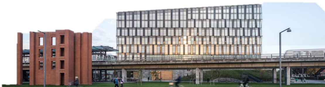
Obr 19 Kontext budovy Nordea se střídavou strukturou natočení okenních prvků
