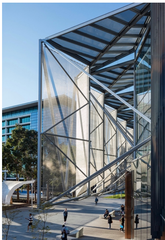
Obr 9 Detail předsazené konstrukce a kovové tkaniny 35
