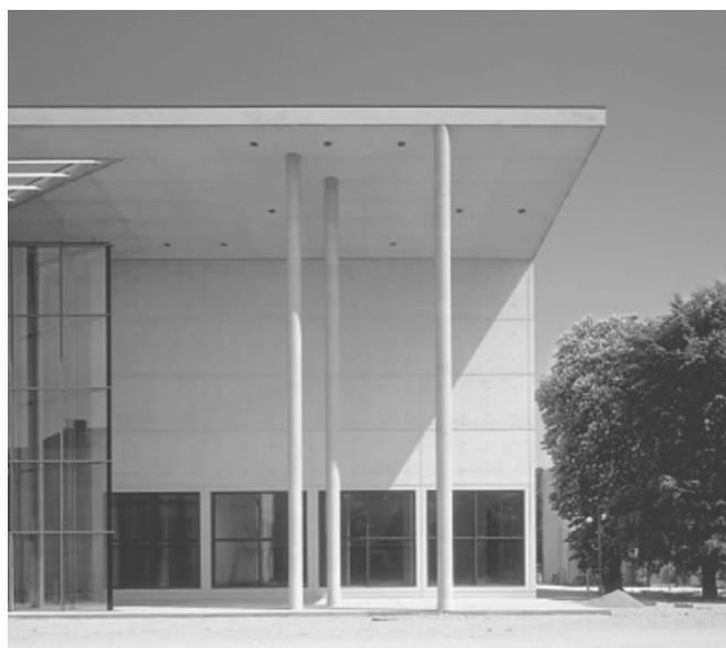
Obr 30 BETONOVÁ DVOUPLÁŠŤOVÁ FASÁDA – Gallery of modern Art
