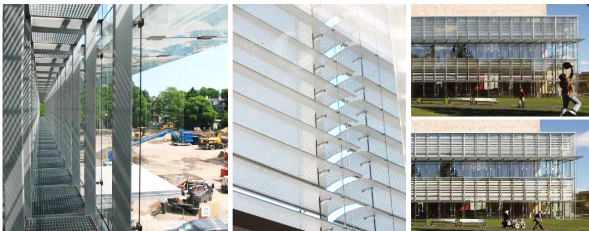
Provětrávaná mezera s pochozím prostorem pro čištění
