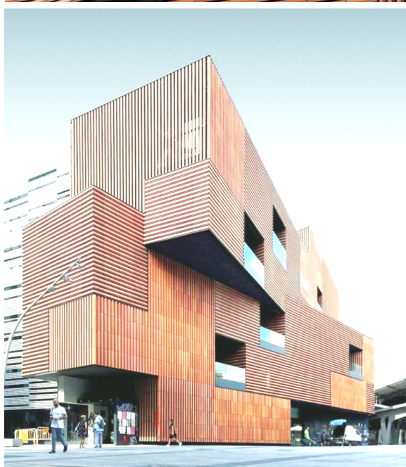
Obr 23 Horizontální a vertikální keramické tvarovky tvoří celistvou fasádu kubických hmot – Escola Massana
