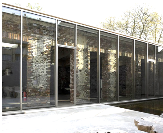
Obr 42 REKONSTRUKCE SKALDU ZA POUŽITÍ TECHNOLOGIE TROMBEHO STĚNY
