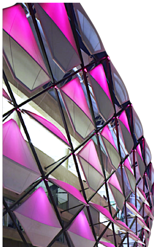
Obr 39 MEMBRÁNOVÁ PŘEDSAZENÁ FASÁDA – HAZZA BIN ZAYED STADIUM
