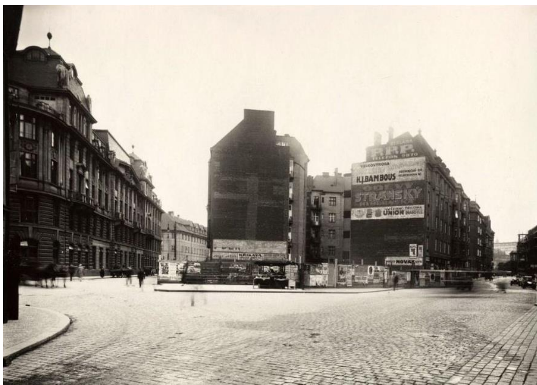
78. Praha, staveniště na parcele čp. 16/I v nároží Kaprovy a Platněřské ulice, dvacátá léta 20. století. Ústav dějin umění AV ČR, odd. dokumentace, sbírka historické fotografie, inv. č. 017609.
