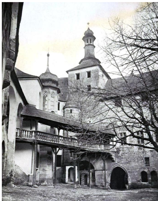
90. Kutná Hora, Vlašský dvůr – severní část nádvoří před Láblerovou rekonstrukcí, před 1893. Ústav dějin umění AV ČR, odd. dokumentace, sbírka historické fotografie, inv. č. 005701.
