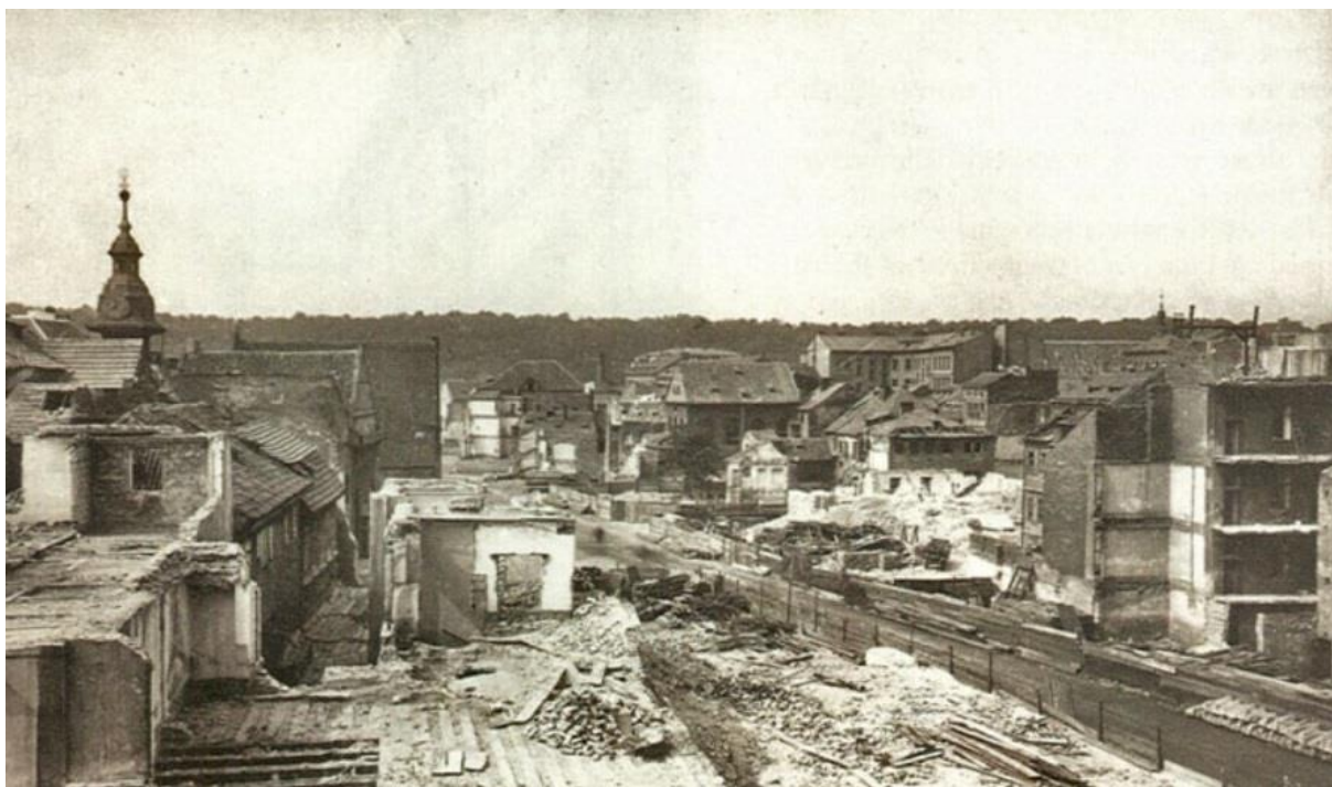
35. Praha, Josefov, demoliční práce v místech budoucí Mikulášské (dnes Pařížské) ulice, po 1900. Foto: archiv autora.
