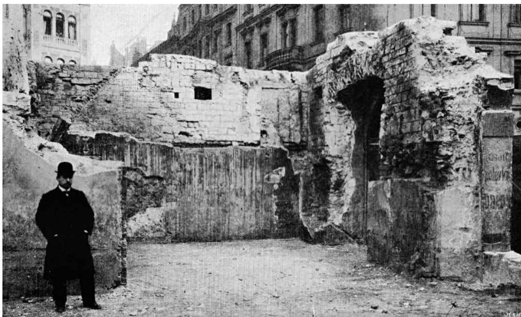
77. Praha, dům čp. 16/I, severní a východní stěny velké místnosti prvního a druhého patra z románské doby. Viditelná je i stopa gotické klenby, která původní dvě románská patra spojila v jediné gotické podlaží (přízemí), 1909. CHYTIL, Karel – HILBERT, Kamil. Dům Andělské koleje na Starém městě (č. p. 16 n. l.). Zprávy komise pro soupis stavebních, uměleckých a historických památek král. hlav. města Prahy V , 1913, s. 73. Reprofoto: autor.
