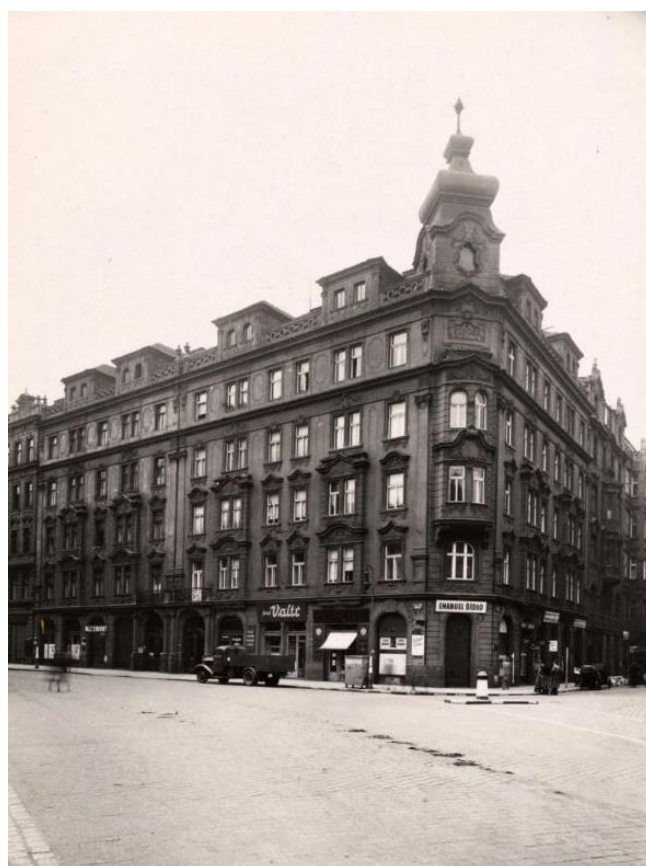
86. Praha, novostavba domu čp. 922/I v nároží ulic Dlouhá a V Kolkovně, dobový snímek. Ústav dějin umění AV ČR, odd. dokumentace, sbírka historické fotografie, inv. č. 018728.
