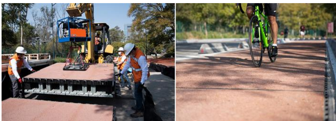
Obr. 14: Modulární design plastové silnice instalované v Mexico City. Zdroj: SmartCitiesWorld [62]
