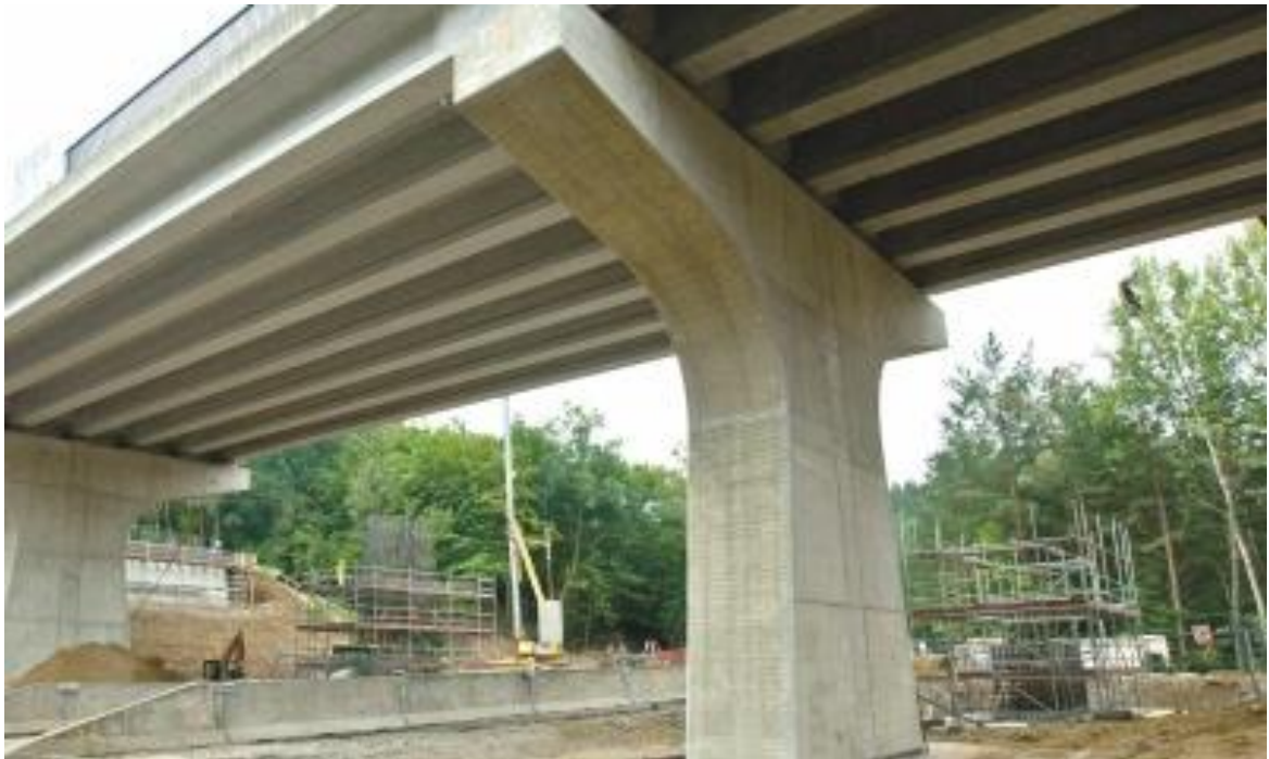
Obr. 3: Levá polovina nově zhotoveného mostu D1-035 v km 29,161 dálnice D1 provedená za 106 dní od započetí demoličních prací mostu původního. Následně pak byla shodným postupem zbudována za dalších 110 dní jeho pravá část, neboť most byl pro zachování provozu vystavěn střídavě ve dvou fázích. Zdroj: Společnost SMP CZ [11].
