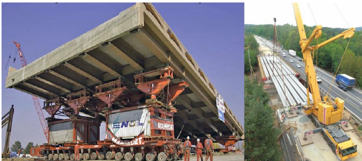
Obr. 18: Instalace hotových celků / prefabrikátů pomocí těžké techniky umožňující kratší omezení dopravního toku. [73] [11]
