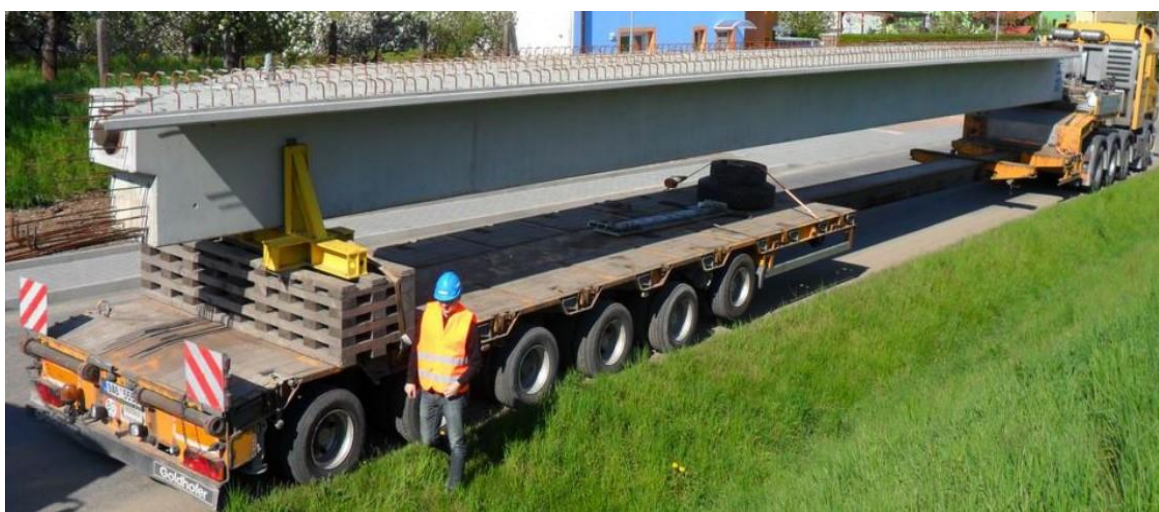
Obr. 20: Transport nosníku (délka 24,5m) pro mostní konstrukci o 7 nosnících v každém směru v rámci projektu Modernizace D1, úsek 25, EXIT 178 Ostrovačice - EXIT 182 Kývalka. Zdroj: KŠ PREFA, a.s., [76]
