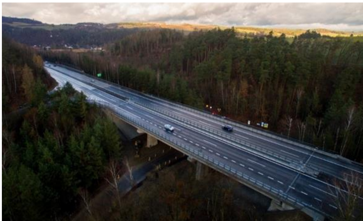
Obr. 25: Vyjma založení původních pilířů (které byly ubourány pouze do úrovně nové základové spáry s ponechanou vyčnívající výztuží a využity jako „pilotové“ založení.), zcela nový most D1-035 v km 29,161 dálnice D1 realizovaný společností SMP CZ, a.s. v roce 2016. Zdroj: [11]
