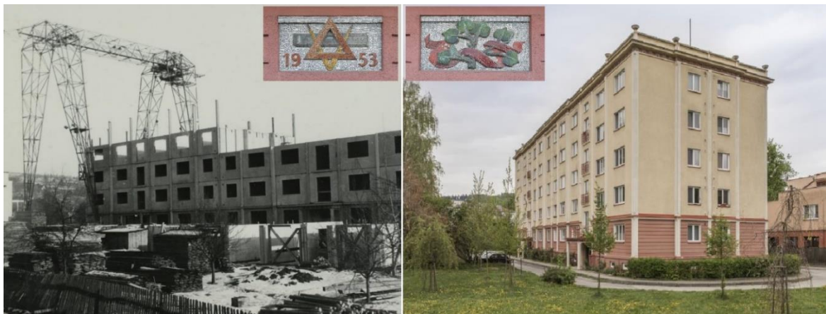
Obr. 2: Svému účelu dodnes sloužící první velký dům montovaný z celostěnových prefabrikovaných panelů v bývalém Československu postavený ve Zlíně podnikem Baťa (resp. Stavosvit, n.p.). Zdroj: [17]
