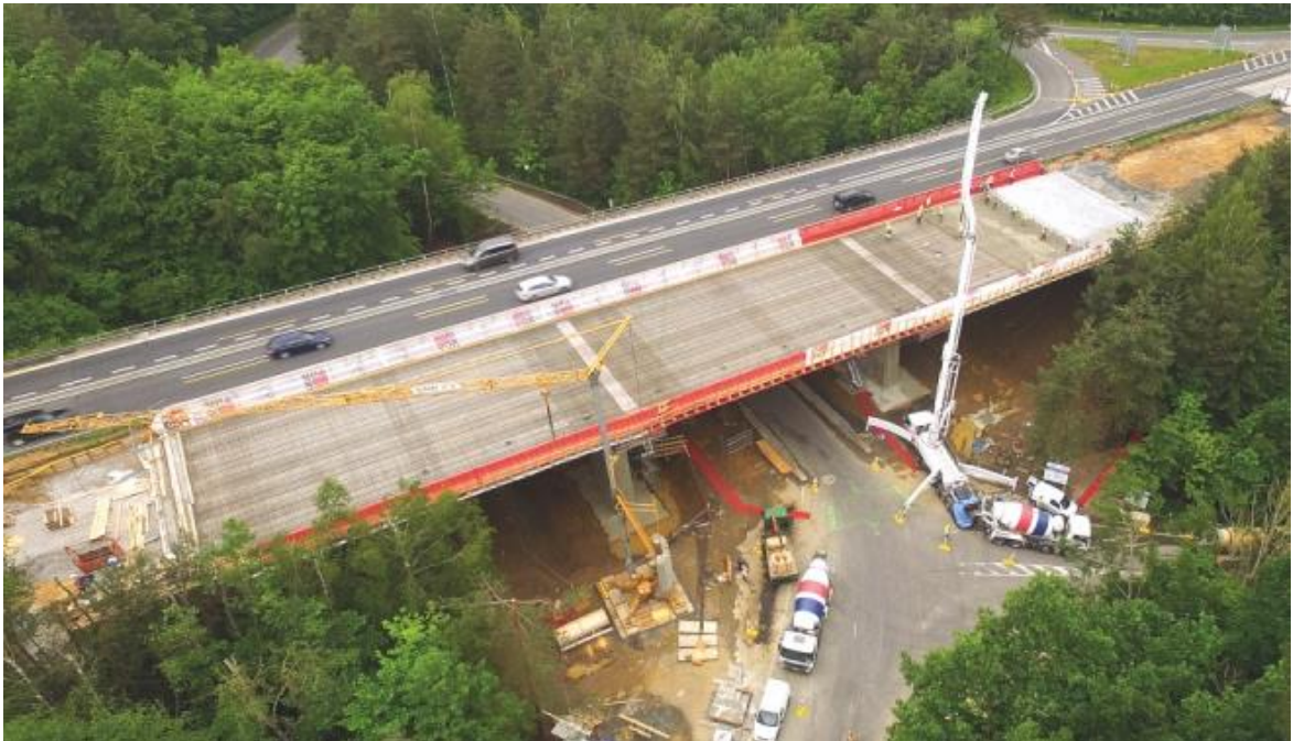
Obr. 4: Betonáž sřážené desky mostovky (levý most) v rámci rekonstrukce a rozšíření mostu D1-035 v km 29,161 dálnice D1. [12]
