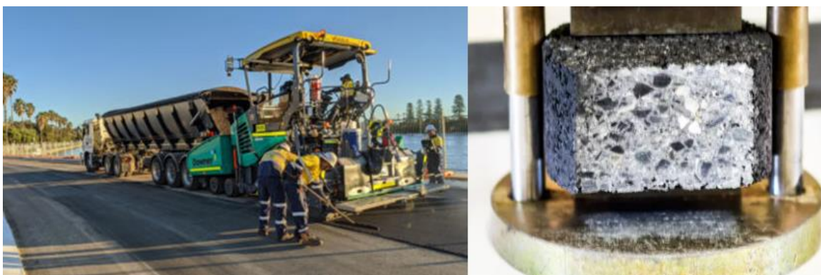
Obr. 12: Asfalt s přísadou TonerPlas vyrobený ze směsných měkkých plastů zde v roce 2020 využitý k obnově povrchu vozovky ve Fremantle v západní Austrálii [60]. Pravá polovina obrázku pak detail materiálu Neo společnosti TechniSoil Industrial používaný v Los Angeles, USA [58]
