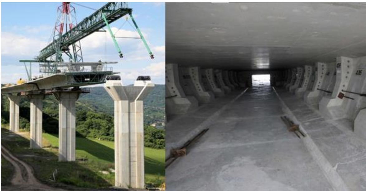
Obr. 23: Segmentové mosty budované na trase dálnice D8 v roce 2014. (Zdroj: ŘSD ČR)
