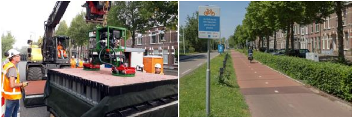
Obr 15: První celoplastová silnice na světě otevřena v obci Zwolle v Nizozemsku v 11/2018. PlasticRoad je 30 metrů dlouhá a obsahuje recyklovaný plastový ekvivalent více než 218 000 plastových kelímků [61].
