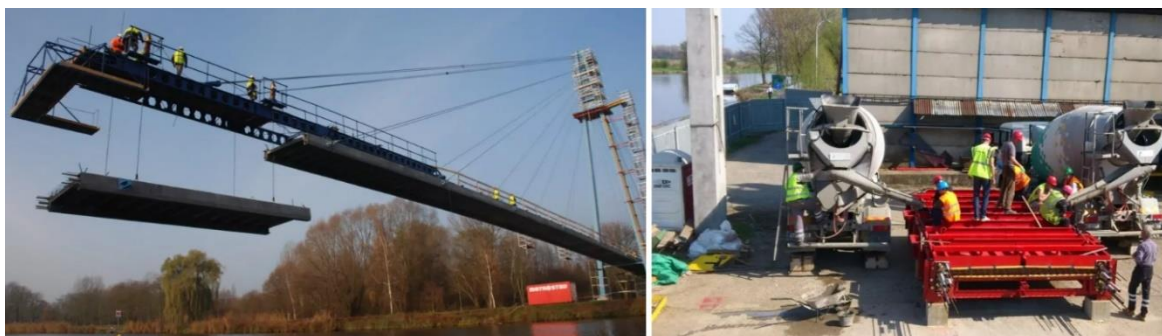
Obr. 11: Lávka z UHPC v Čelákovících a využití formy pro betonáž segmentů v blízkosti realizace (Metrostav, 2014).
