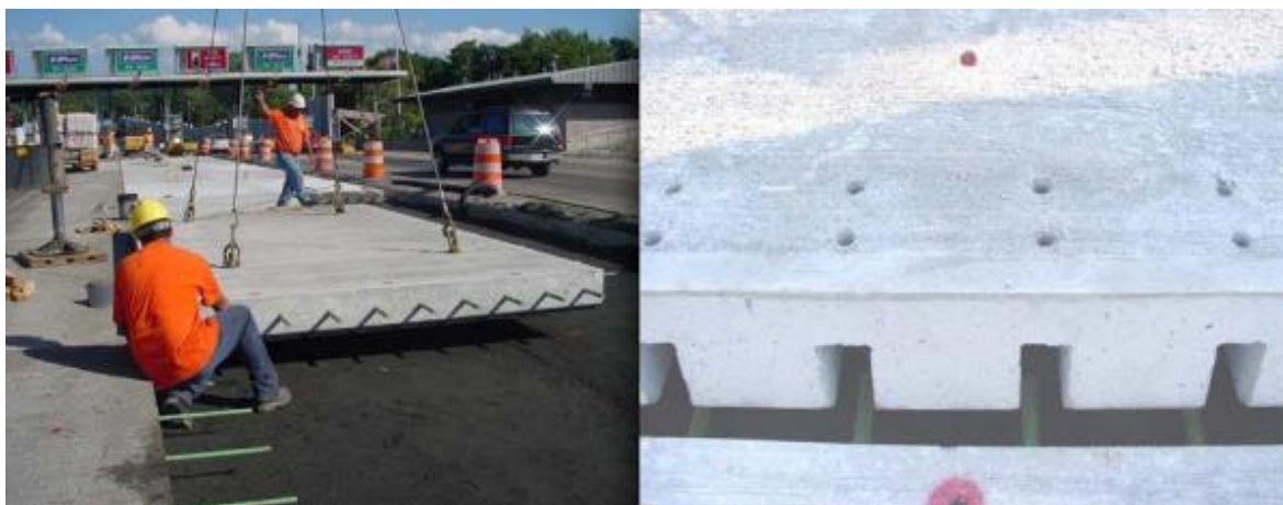
Obr. 16: Instalace světově nejrozšířenějšího vozovkového panelového systému Super-Slab společnosti Fort Miller. Zdroj: Fort Miller Company [68]
