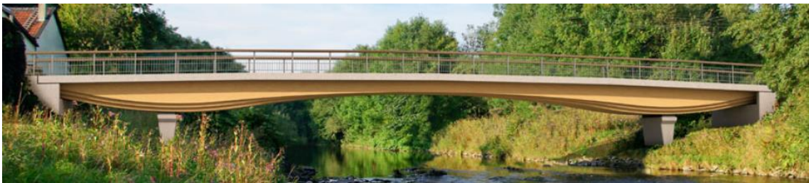
Obr. 41: Most pro dopravu s těžkým nákladem překračující řeku Agger v Lohmar Schiffarth v Německu, délka 40 m, šířka 4,75 m. Využívá ve své konstrukci Accoya wood, deska z běžného betonu. [71]
