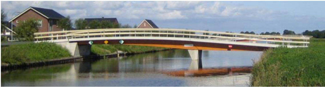
Obr. 40: Most v provincii Gronigen v Nizozemí, délka 40 m (16+24m), šíře 4 m. Využívá ve své konstrukci Accoya wood, deska z běžného betonu. [71]
