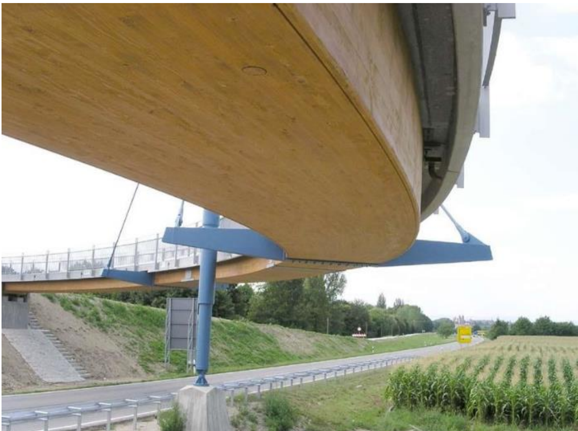
Obr. 42: Obloukový most pro pěší a cyklisty v Hochstettenu, postavený v roce 2003. Dřevěný nosník je ze dřeva lepeného do bloku spojeného s mostovkou z běžného betonu. [72]
