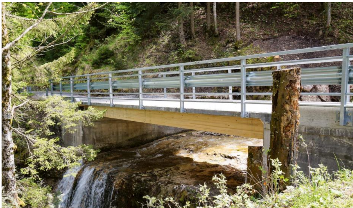
Obr. 47: Pohled na silniční most přes Rotenfluebach na Rigi Fruttli ve Švýcarsku [75]
