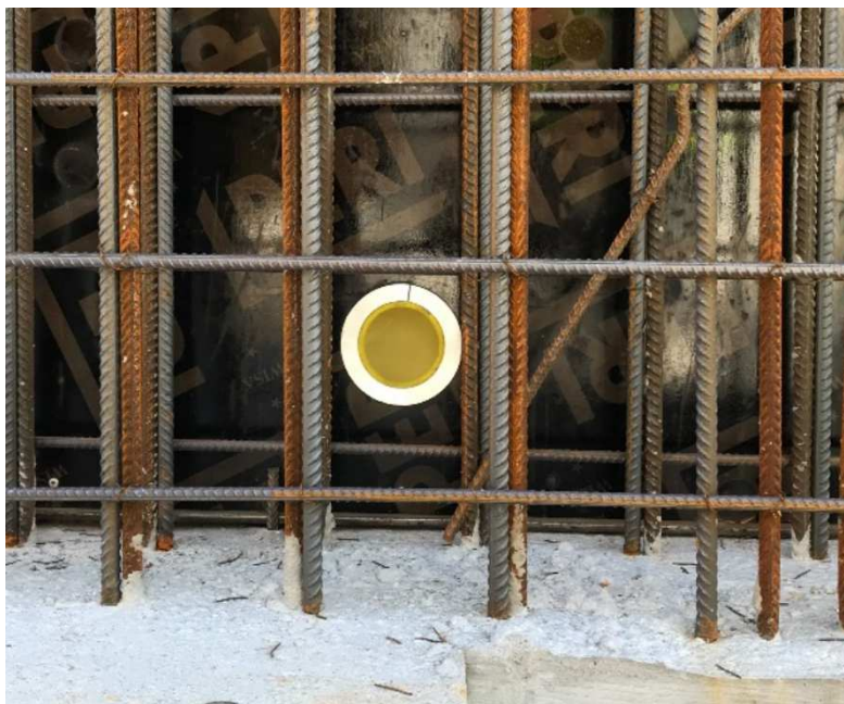
Obr. 4.28: Zabudovaná komora v bednění stěny – pohled zvnitřku stěny
