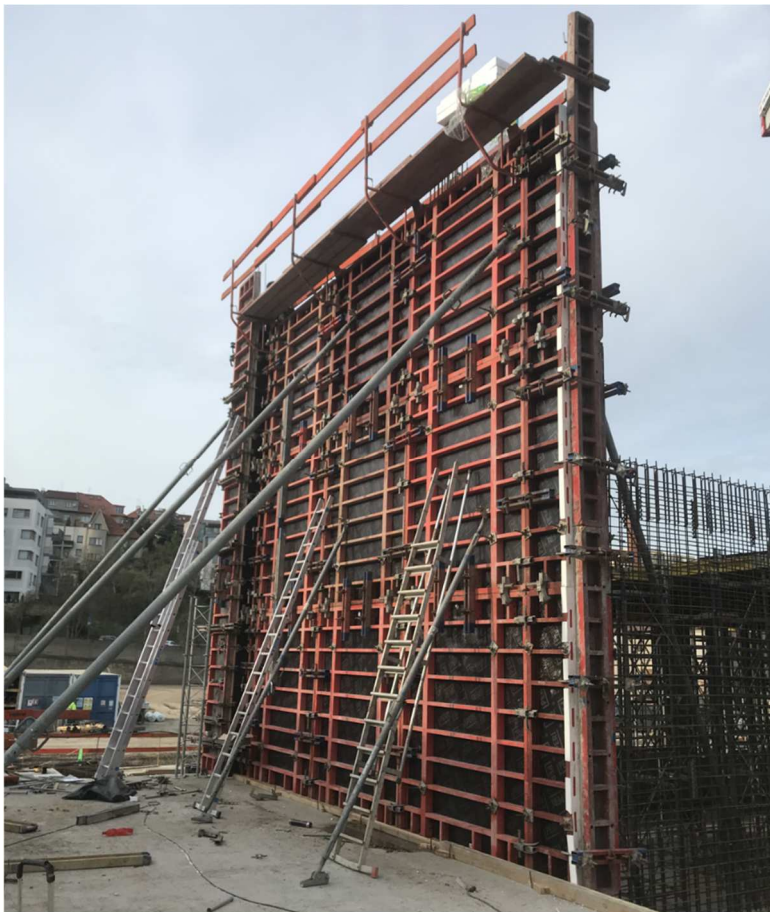
Obr. 1.1: Bednění výšky 7,8 m určené pro železobetonovou monolitickou stěnu, která byla betonovaná pomocí upraveného samozhutnitelného betonu
