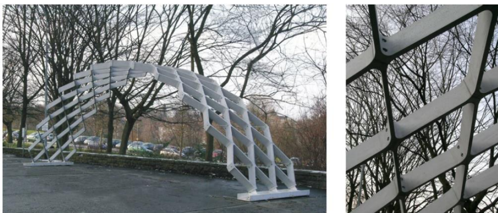
Obrázek 3 Model konstrukce zastřešení haly s kosočtvercovou příhradovinou s rozpětím 3 metry [2]
