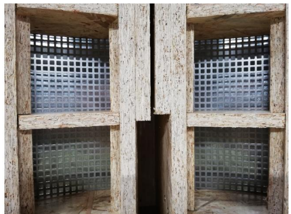
Obrázek 99 Výroba bednění
