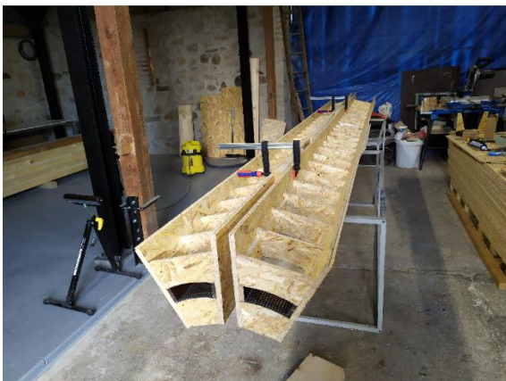
Obrázek 99 Výroba bednění
