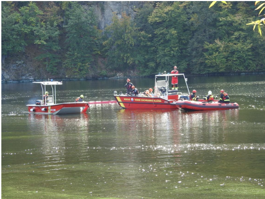
Obrázek 24 - Instalace noré stěny pomocí dvou posádek - tvar "O" [Zdroj: vlastní]
