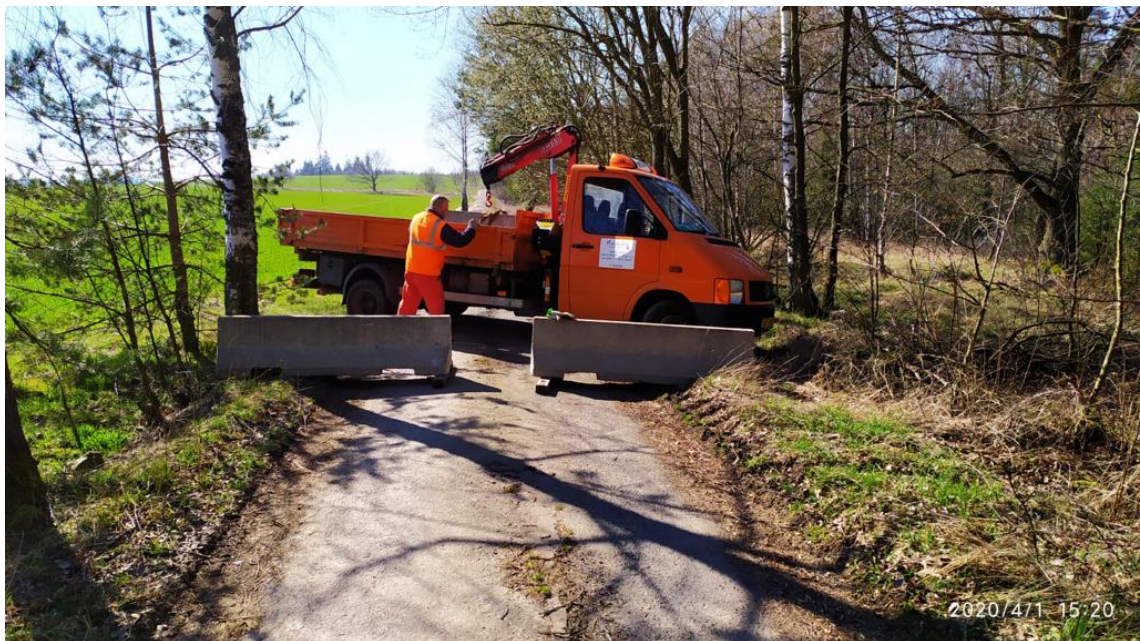
Obr. 1 – Instalace zátaras v blízkosti hraničních přechodů mezi KVK a SRN
