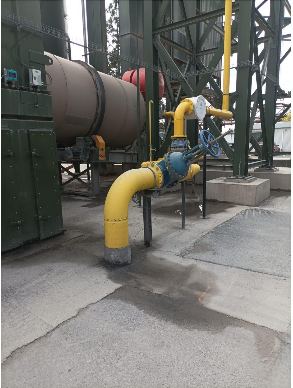
Příloha 8 Prívod plynu pro soustrojí obalovny
