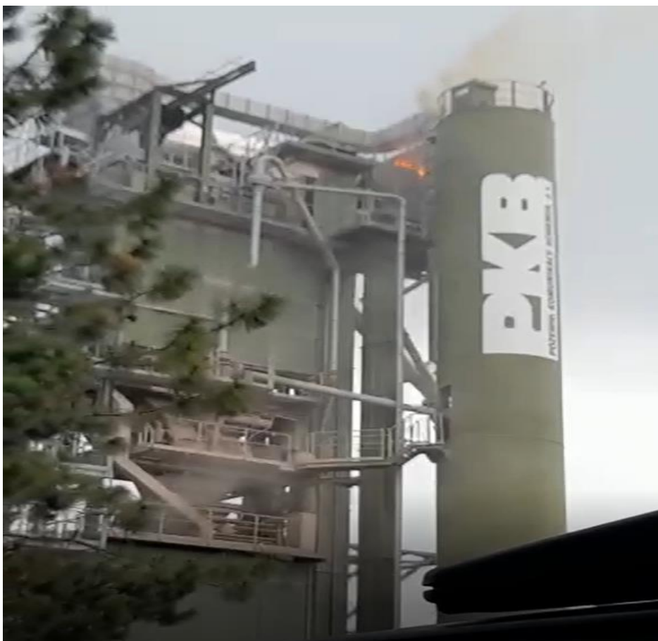
Obrázek 7 Požár obalovny asfaltových směsí PKB (zdroj vlastní)
