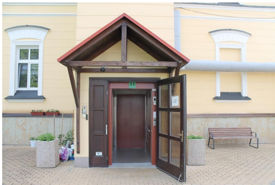
Obrázek 11 – Evakuační výtah – Luisin dům [zdroj: vlastní]
