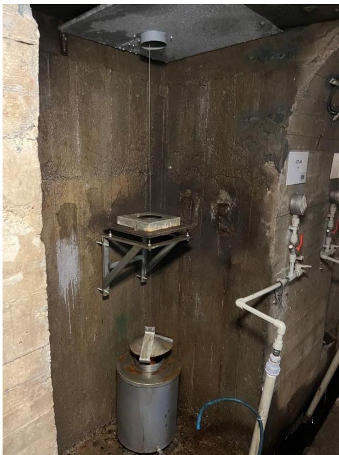
Obrázek 18 Zařízení pro měření náklonu hráze [zdroj vlastní]
