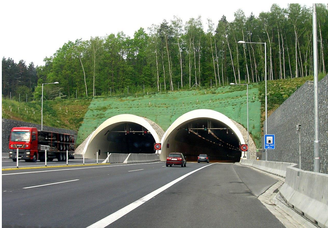
Obrázek 4: Vjezd do tunelu Valík [16]
