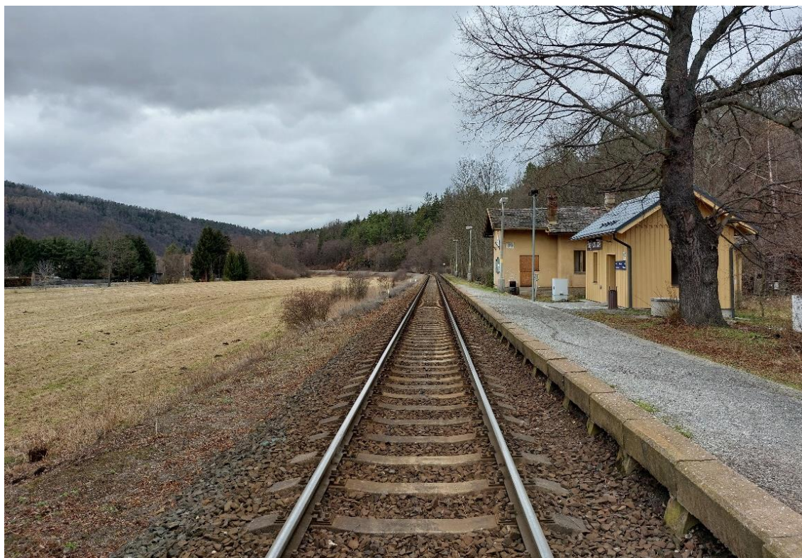
Obr. 17: Současná podoba zastávky Rejkovice (foceno z přejezdu P554). V těchto místech bude zřízena výhybka a nová kolej bude umístěna vlevo od stávající. Při výstavbě dojde také k úpravě zastávky a vybudování nových nástupišť; foto: autor
