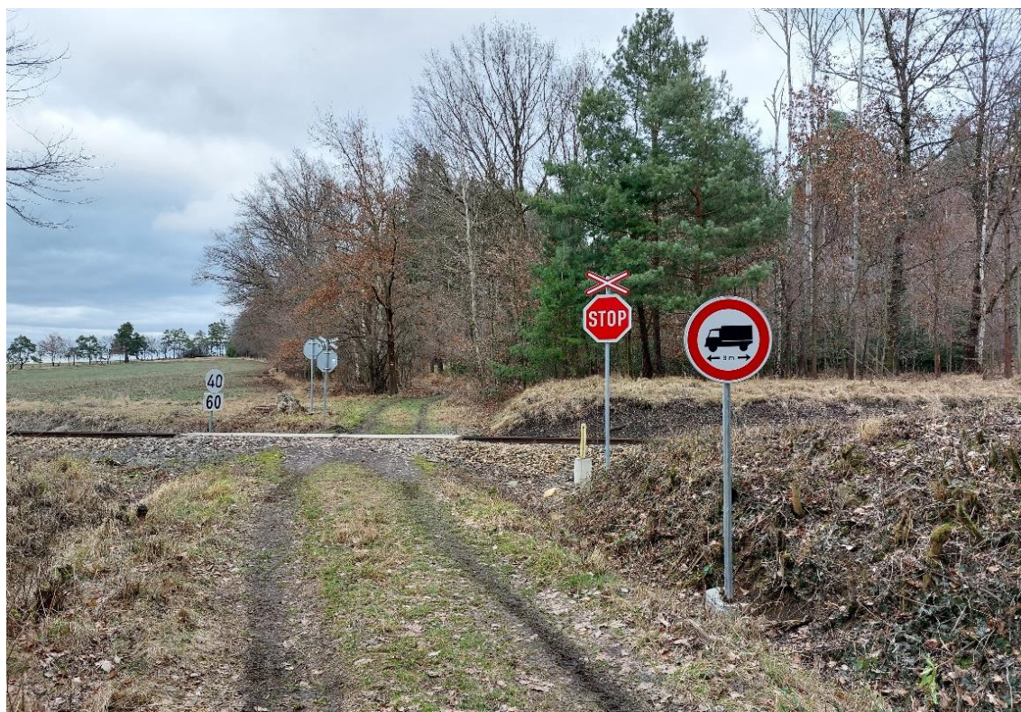
Obr. 15: Železniční přejezd P556 v mezistaničním úseku Jince – Lochovice. Z důvodu omezených rozhledových poměrů je zde snížena traťová rychlost ve směru od Jinců na 40 km/h a navíc je zde umístěna dopravní značka B17, která zakazuje vjezd vozidel, jejichž délka přesahuje 8 metrů. Vzhledem ke stavu této polní cesty by takové vozidlo mělo problémy k přejezdu vůbec dojet; foto: autor
