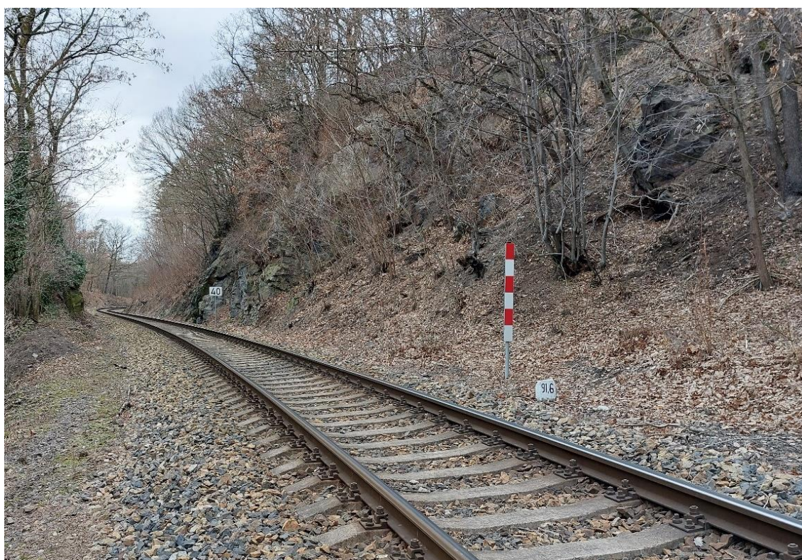
Obr. 16: Železniční trať v úseku Rejkovice – Lochovice, tedy v úseku se zhoršenými směrovými parametry tratě, která zde kopíruje řeku Litavku. Zde navíc i s významným snížením traťové rychlosti před přejezdem
