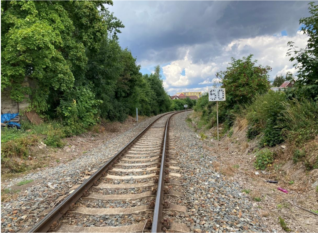
Obrázek 45: Rychlostníky N před přejezdem P754 v Boru; autor
