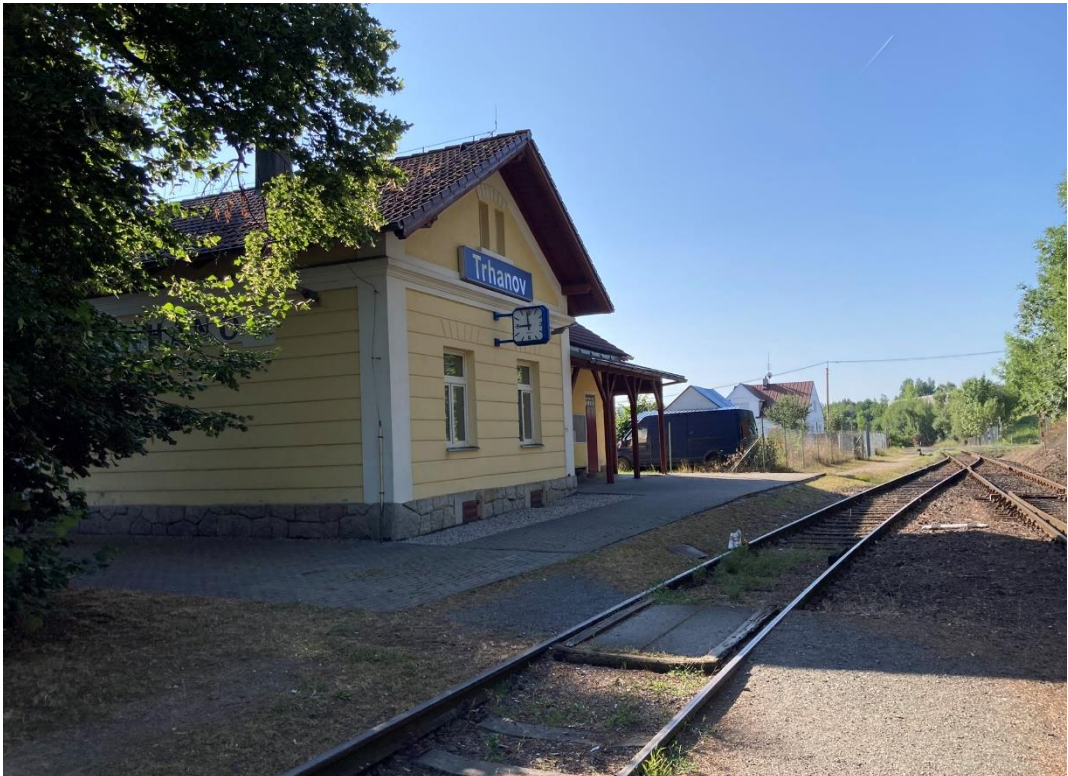
Obrázek 30: Přístřešek (bývalá výpravní budova) v zastávce s nákladištěm Trhanov; autor
