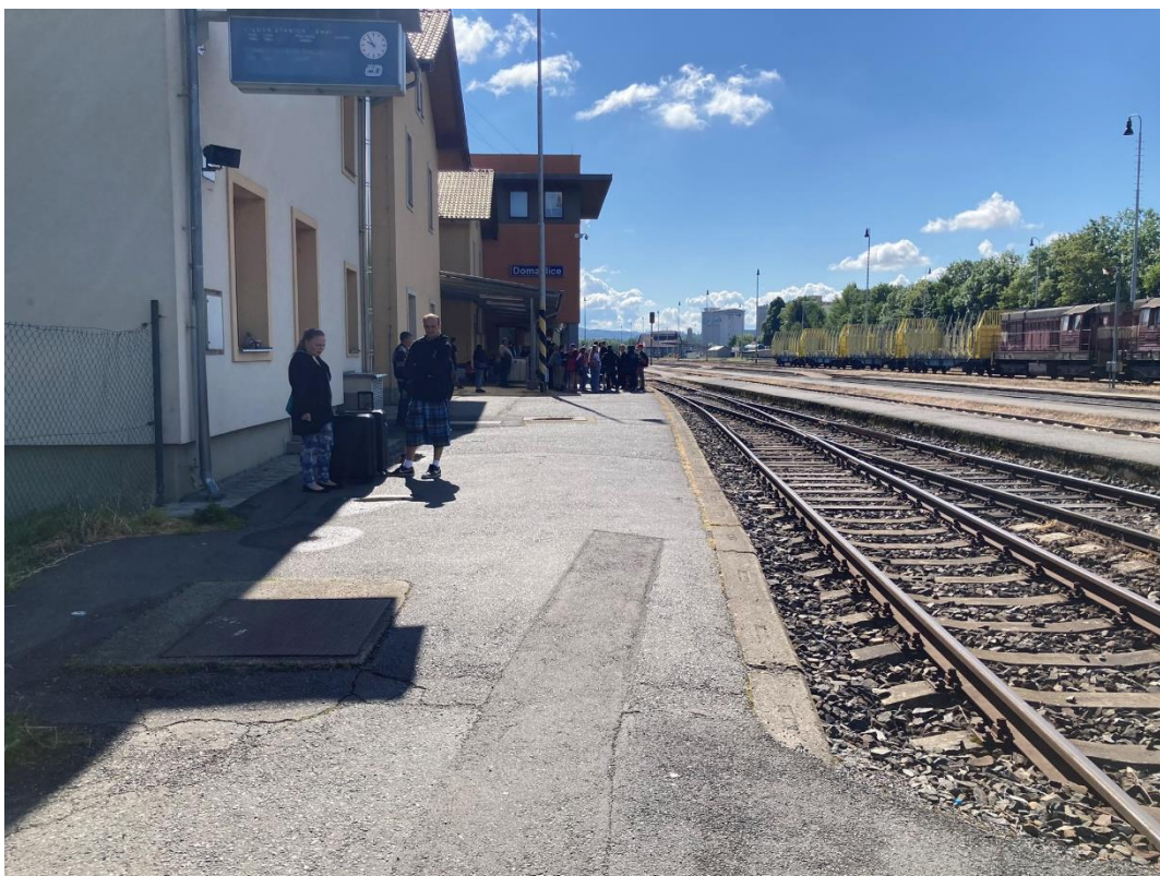
Obrázek 25: Stávající stav žst. Domažlice; autor
