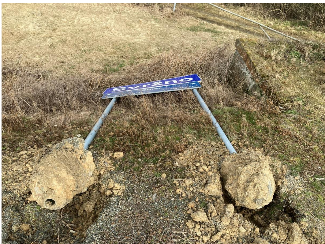
Obrázek 40: Nevyhovující technický stav zastávky Svržno; autor
