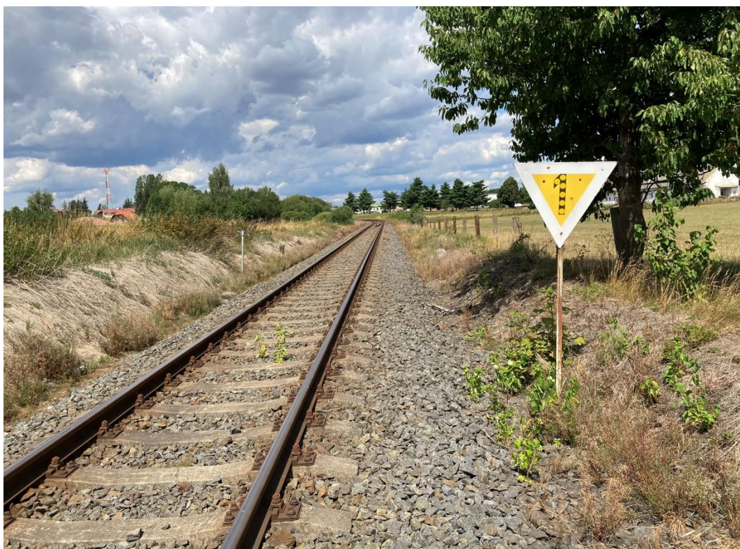
Obrázek 52: Předvěstník před přejezdem P762 ve Starém Sedlišti; autor
