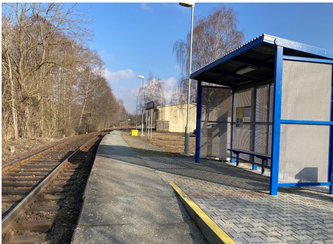
Obrázek 41: Aktuální stav zastávky Újezd Svatého Kříže; autor
