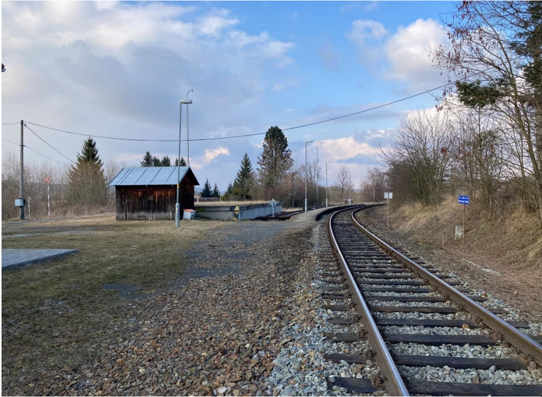
Obrázek 37: Současný stav zastávky s nákladištěm Mutěňín; autor
