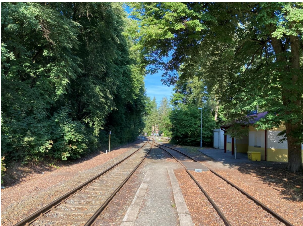
Obrázek 28: Stávající stav zastávky Havlovice, pohled ve směru do Klenčí; autor
