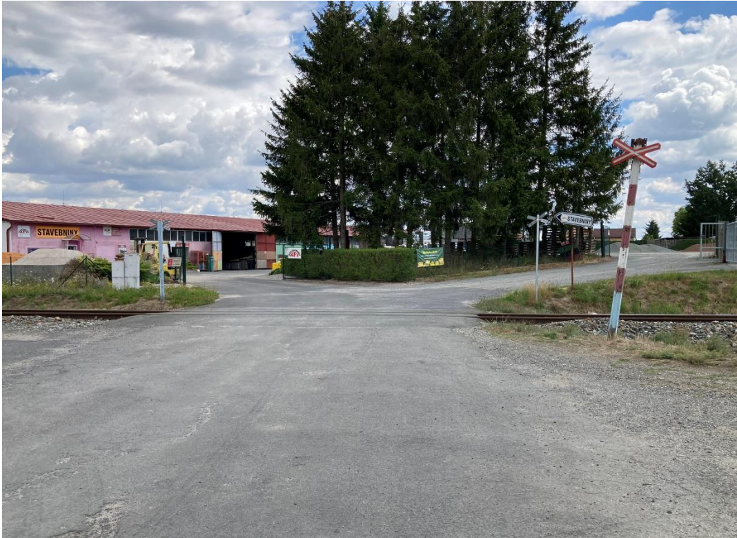
Obrázek 47: Současný stav přejezdu P754 v Boru; autor
