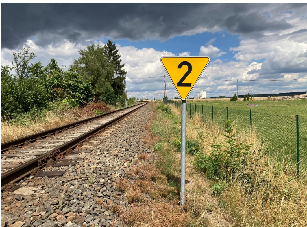
Obrázek 44: Předvěstník před přejezdem P754 v Boru; autor
