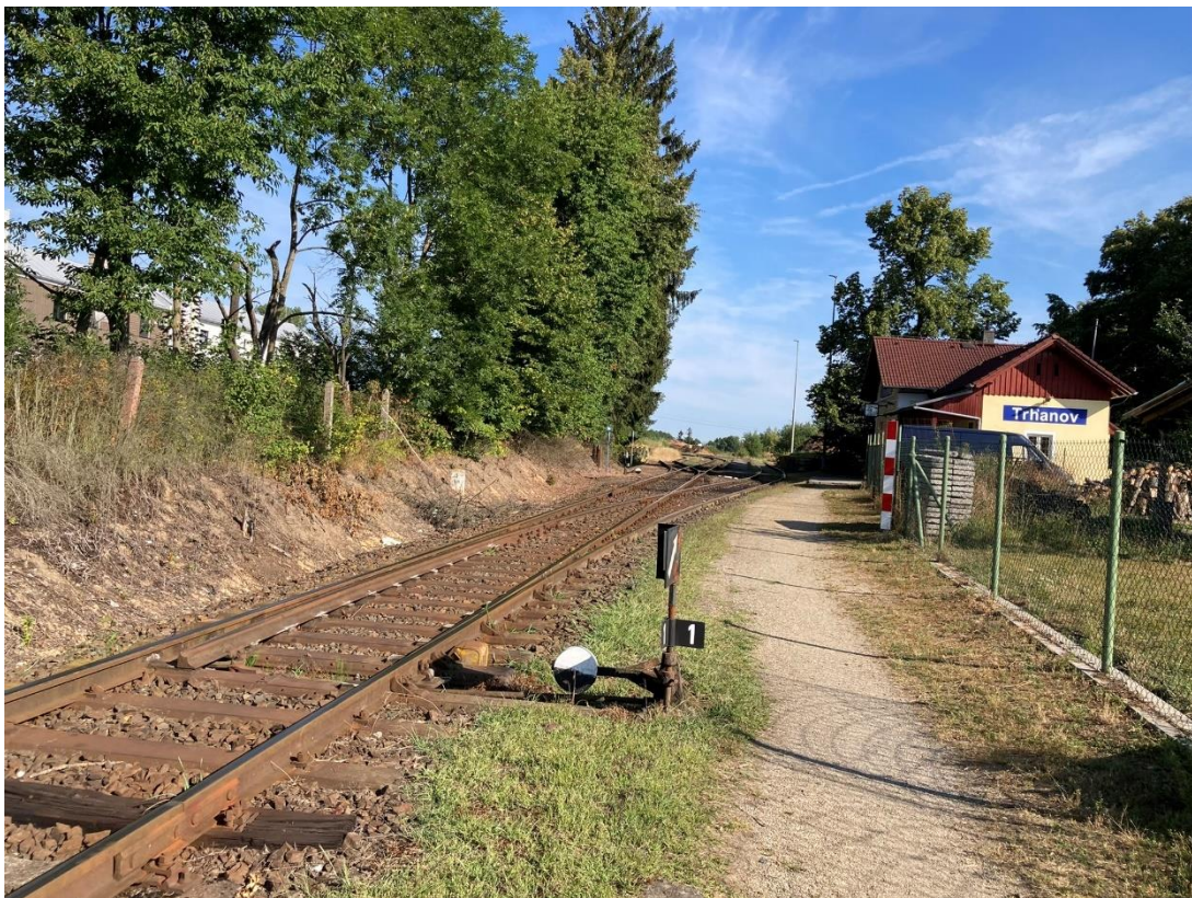
Obrázek 24: Stávající stav zastávky nákladíště Trhanov, pohled ve směru od Pily; autor
