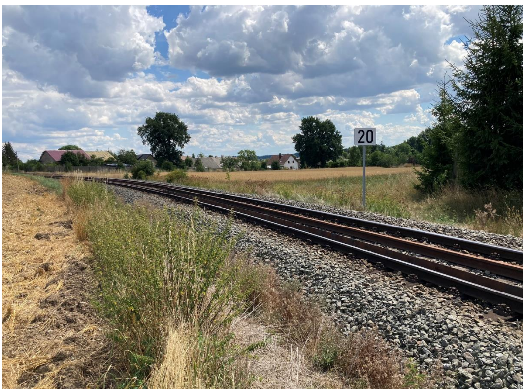
Obrázek 56: Rychlostník N platný před přejezdem P762 ve Starém Sedlišti ve směru do Boru; autor
