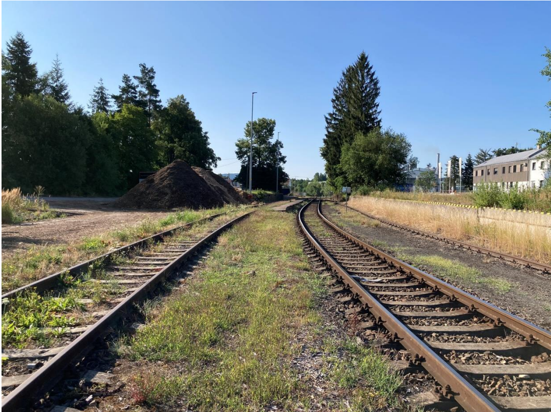
Obrázek 23: Stávající stav zastávky nákladíště Trhanov, pohled ve směru od Klenci; autor
