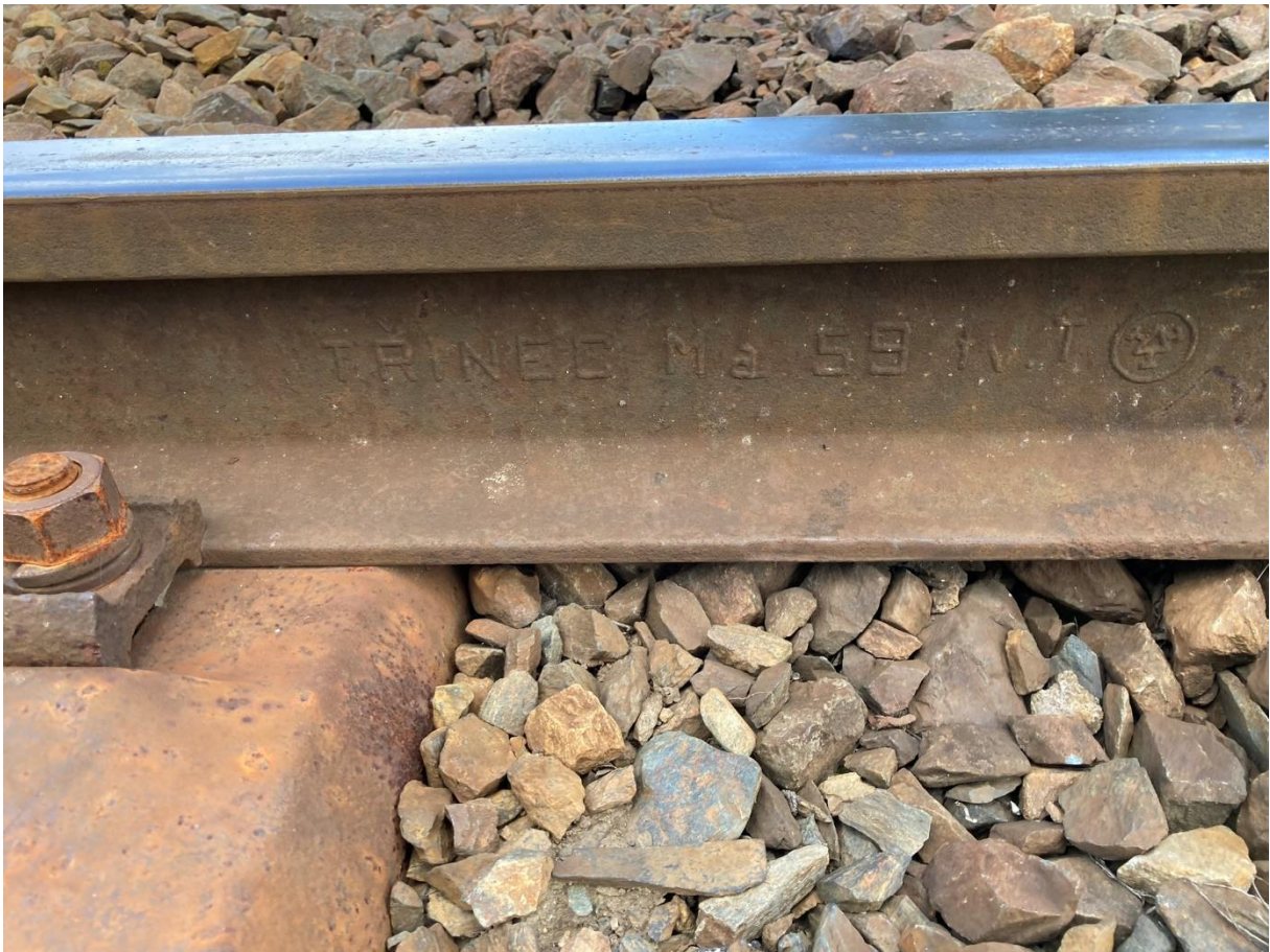
Obrázek 7: Kolejnice tvaru T z roku 1959 v dopravě D3 Staré Sedliště; autor
