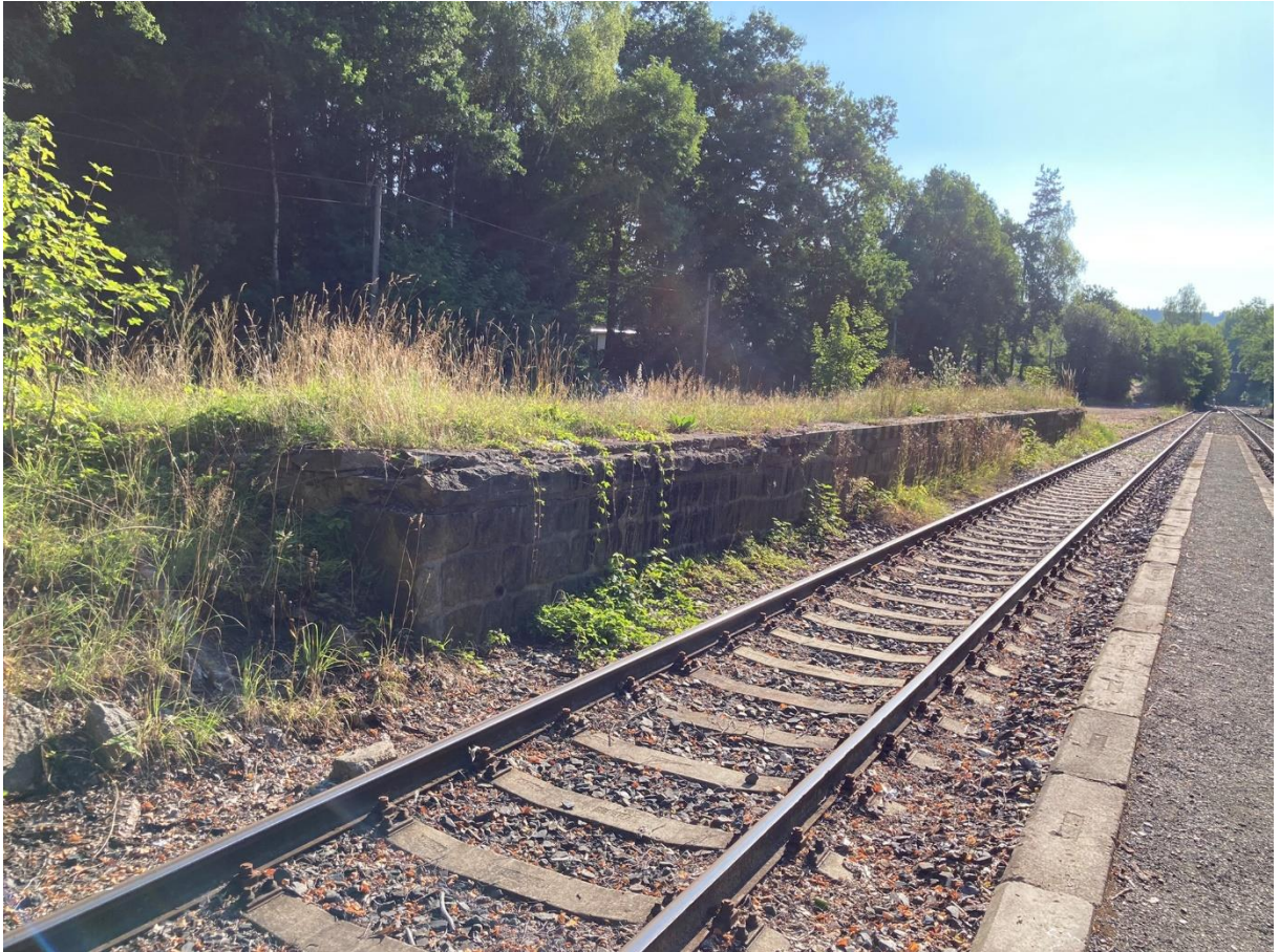
Obrázek 22: Stávající stav zastávky Havlovice, pohled na rampu; autor
