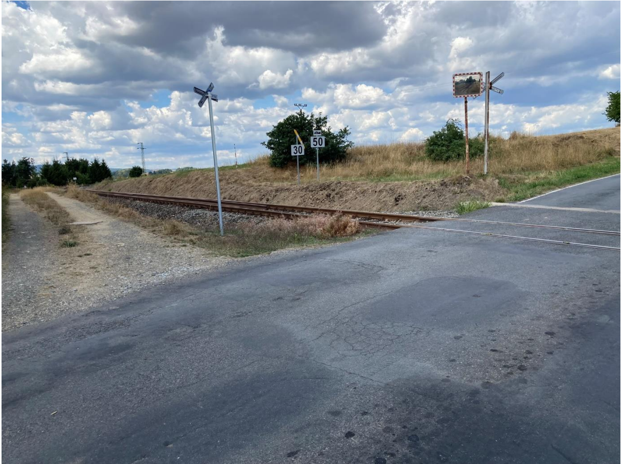
Obrázek 18: Omezený rozhled na přejezdu P762 ve Starém Sedlišti, autor
