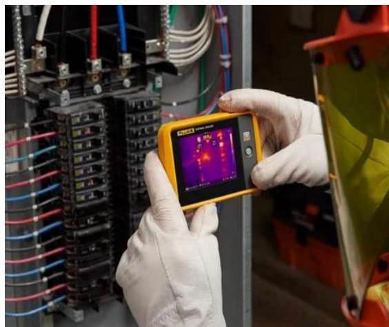
Obr. 17 - Ruční termokamera Fluke PTi120 [10]
