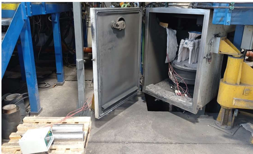
Obr. 34 Měření teplot výrazně zchladlé skořepiny
