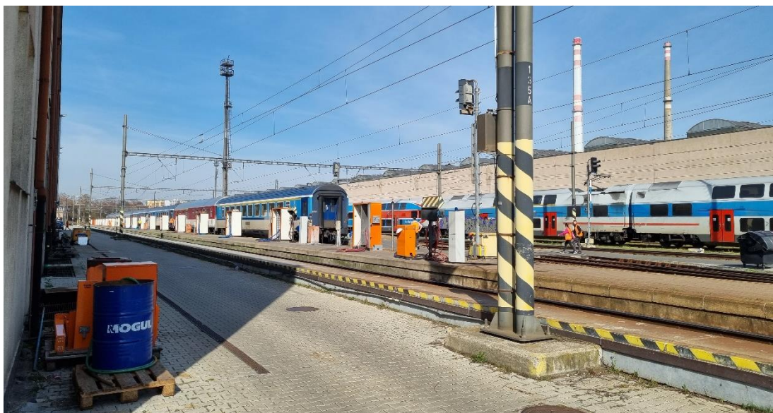
Obrázek 14 - pohled na sanitární koleje v prostoru ONJ Praha, pravidelně rozmístěná zařízení jsou tzv. odsávací skříně, foto: Martin Chlup, 04/2022
