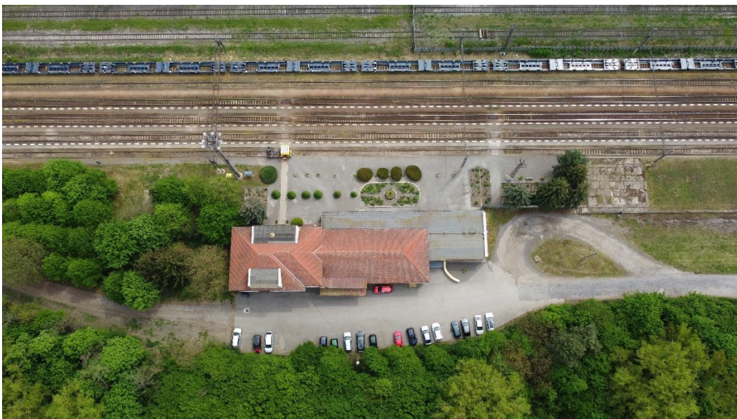
Obrázok 10 - Železničná stanica Bánovce nad Ondavou, pohľad na výpravnú budovu (zdroj: Autor, 6.5.2022)
