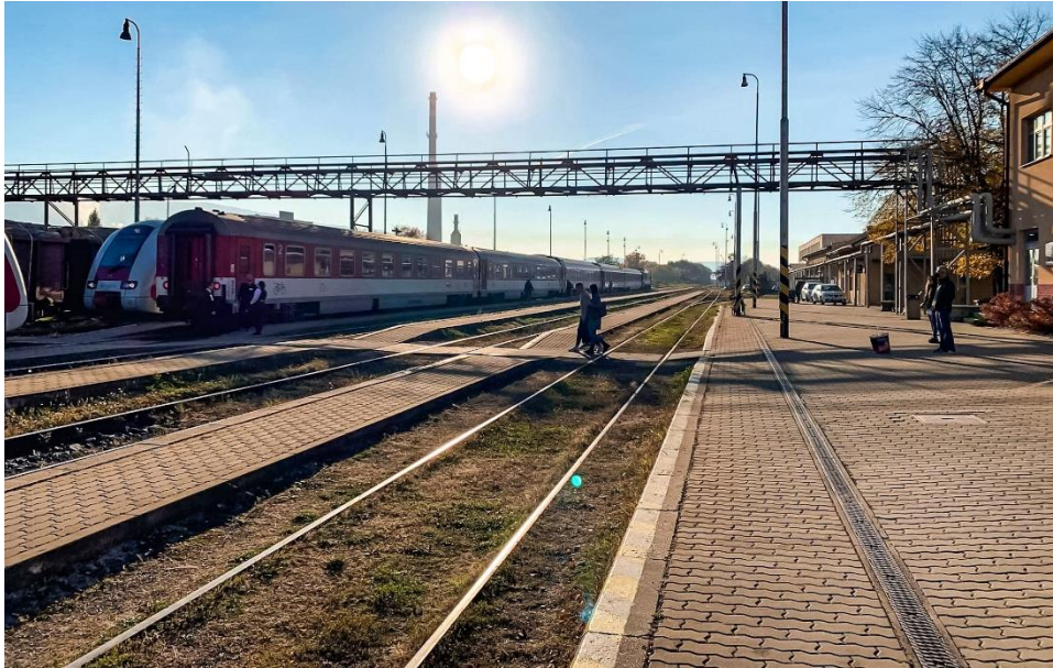
Obrázok 14 - Železničná stanica Humenné, pohľad na nástupišťa (zdroj: Autor)
