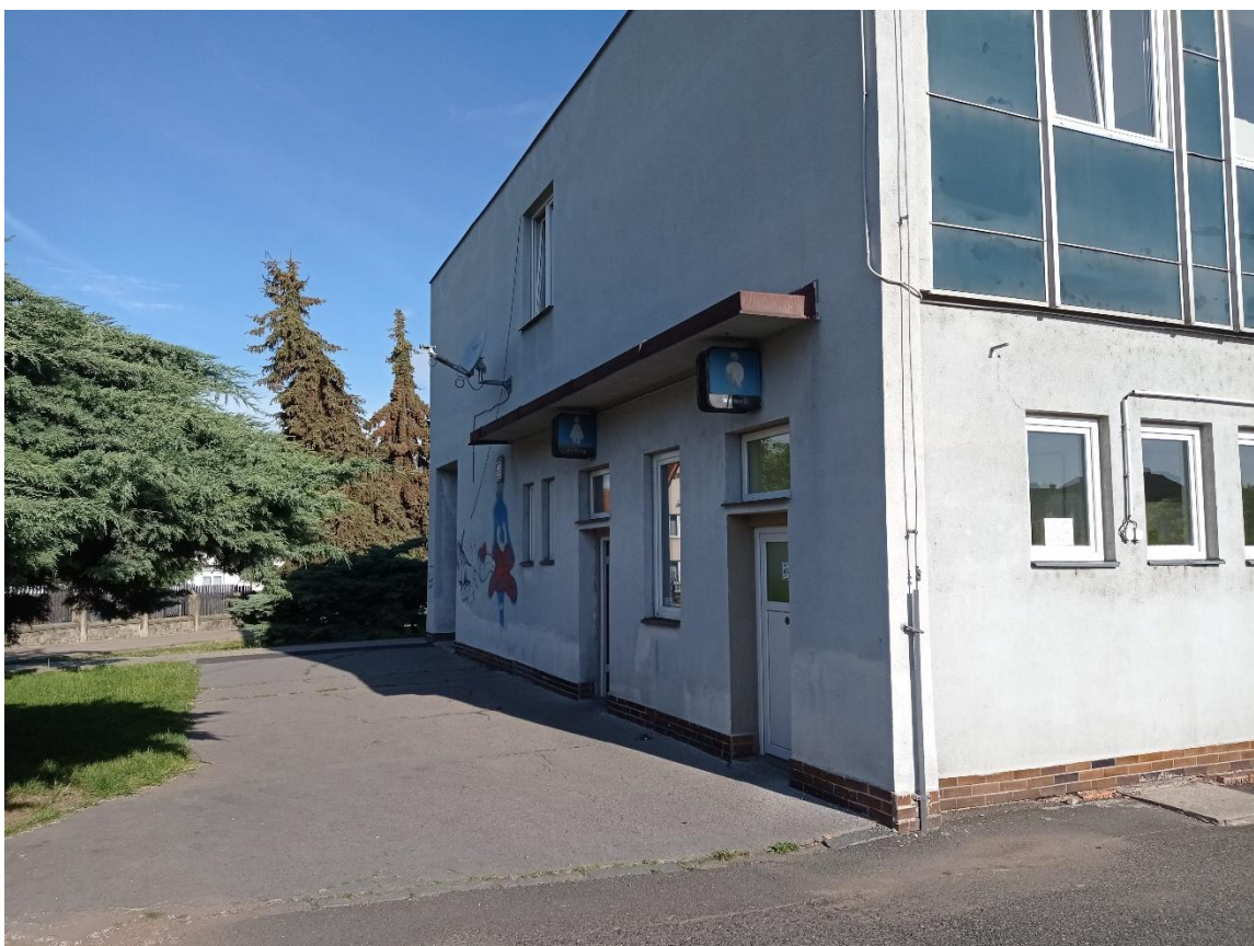
Obrázek 20 - Vchod na WC zvenku budovy
