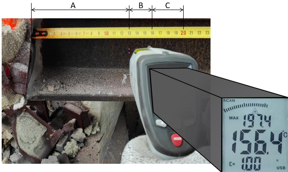
Obr. 24 – Měření teploty povrchu IR teploměrem (dvě červené tečky na objektu ukazují místo, ve kterém se teplota zjišťuje)
