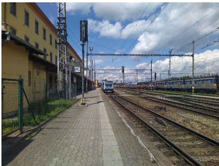
Obrázek 16 – stanice Jihlava, nástupiště před výpravní budovou (zdroj Autor)
