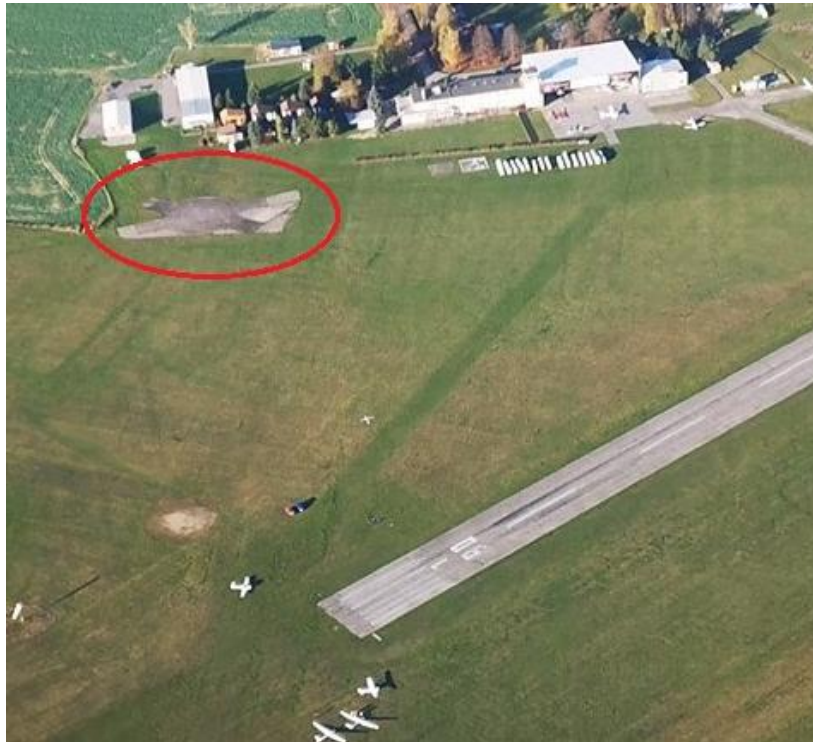
Obrázek 16 - Bývalá zpevněná modelářská dráha na letišti Hosín
