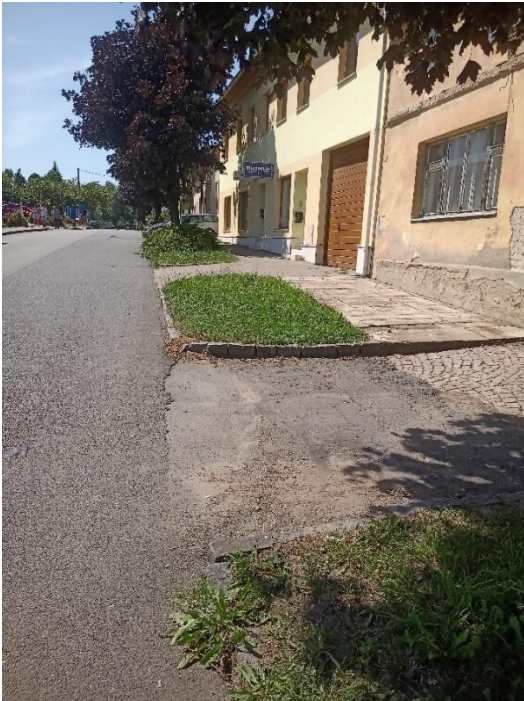
Obrázek 16 Ulice Dobrovského, pohled ze severu na jih – ukázka provedení pásu pro chodce se sjezdu na západní straně komunikace (zdroj: autor)
