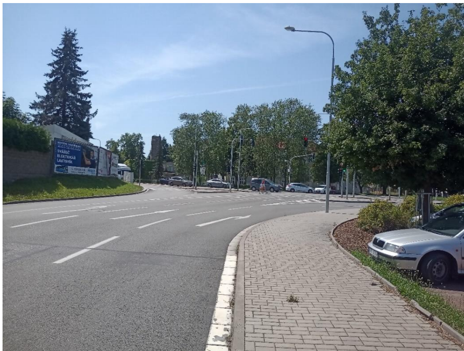
Obrázek 21 Světelně řízená křižovatka ulic Hradecká, Karosářská a Vraclavská (pohled z ulice Karosářská) (zdroj: autor)
