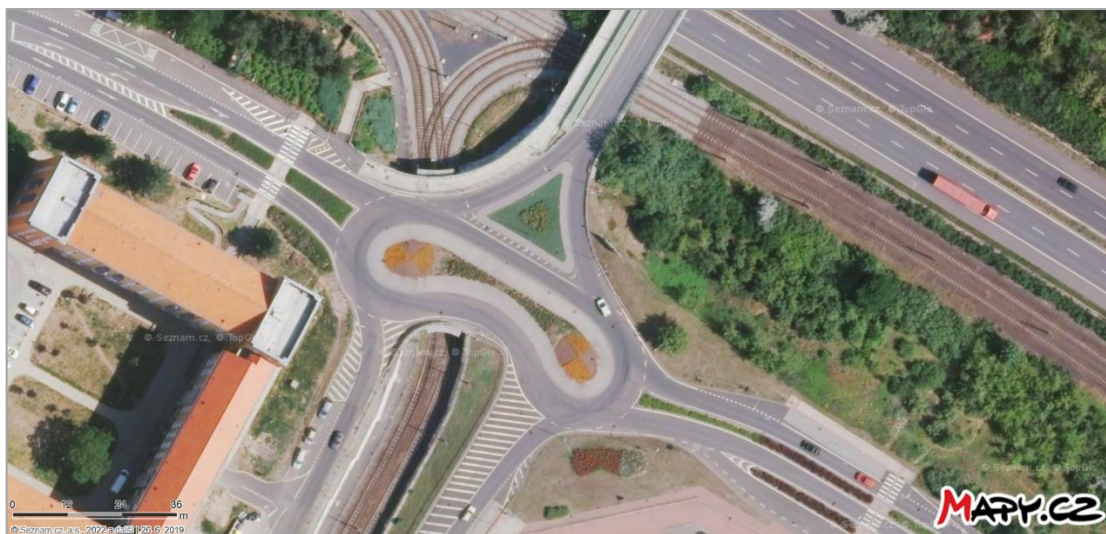
Obrázek 35 – Příklad realizované JOK tvaru „přesýpací hodiny“ z Mostu (zdroj: [53])
