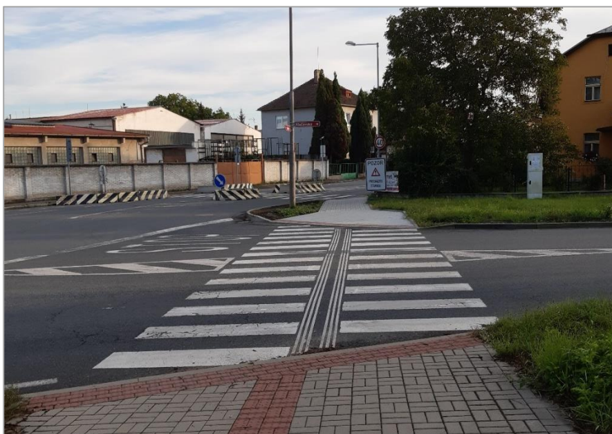
Obrázek 26 – Přechod pro chodce v Klučovské ulici s chybným provedením hmatových prvků pro nevidomé (zdroj: vlastní tvorba)
