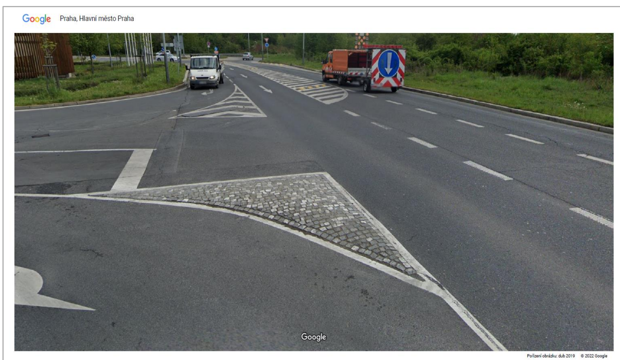
Obrázek 19 – Příklad realizovaného směrovacího ostrůvku z kamenné dlažby na Černém Mostě (zdroj: [57])
