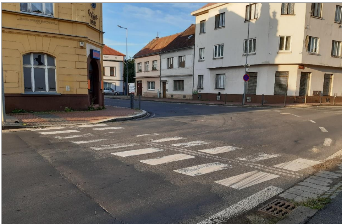
Obrázek 10 – Nevhodně provedený přechod pro chodce přes ulici Jana Kouly (zdroj: vlastní tvorba)
