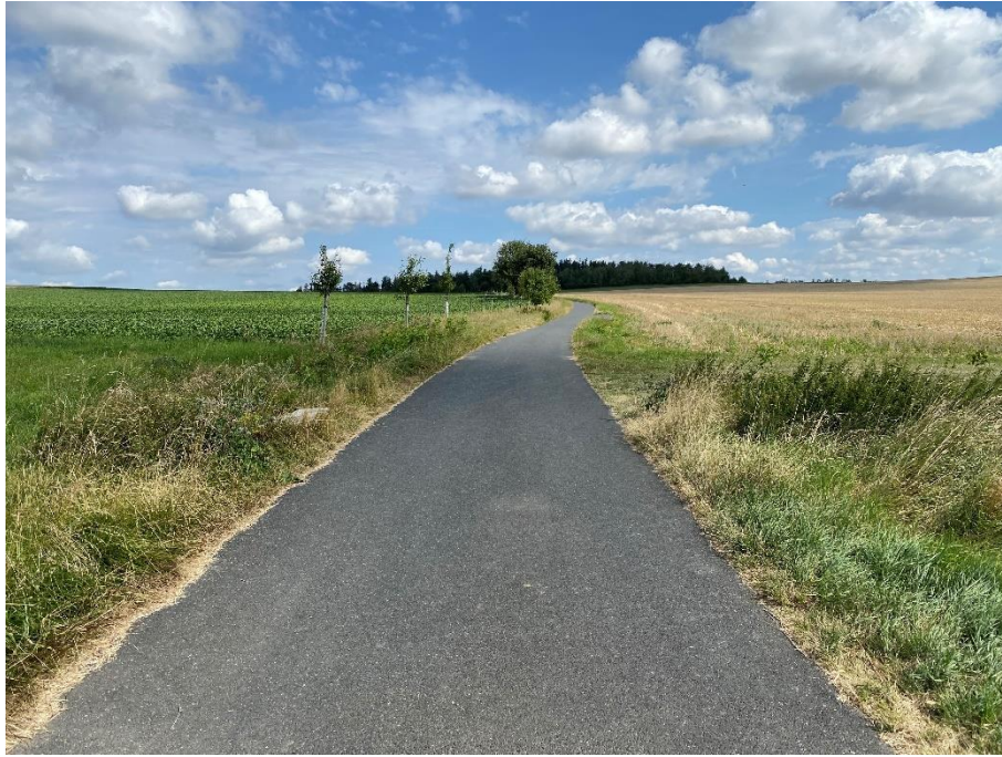
Obrázek 39: Účelová komunikace 320108258 směrem Červené Pečky [37]
