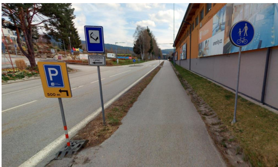
Obrázek 36: Nevhodně oddělená komunikace II/163 a stezka pro chodce a cyklisty (Kobylnice u Lipna nad Vltavou) [16]
