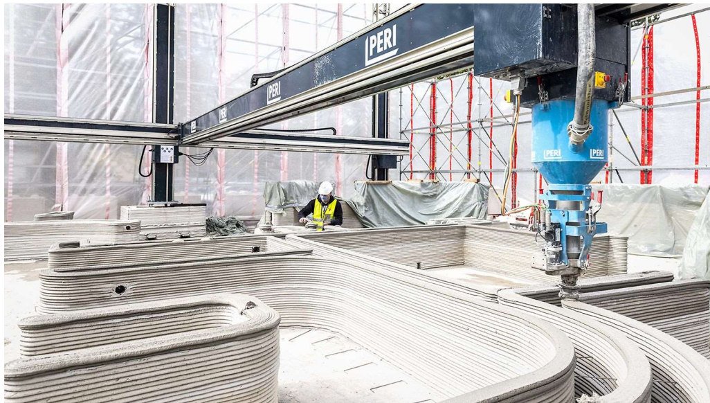
Obrázek 16 Probíhající tisk budovy (Sweet, 2020)
