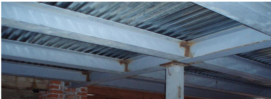
Obrázek 3 Trámová konstrukce střechy [28]
