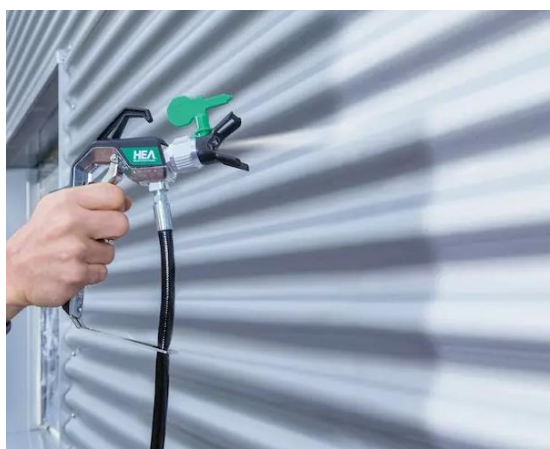
Obrázek 12 Aplikace NH pomocí vysokotlaké pistole
