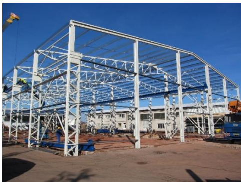
Obrázek 2 Rámová konstrukce haly v systému VEDE [26]
