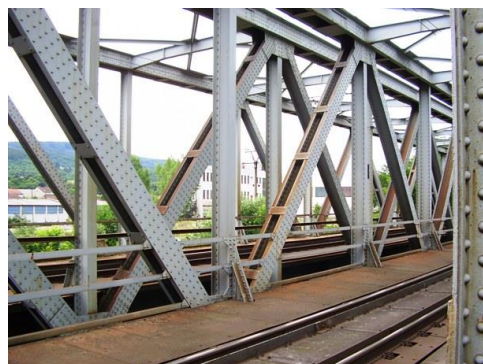
Obrázek 1 Příhradová konstrukce ocelového mostu [27]
