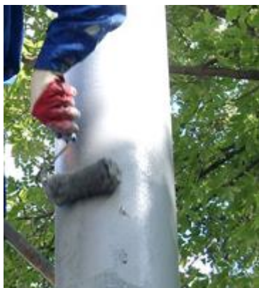
Obrázek 11 Aplikace protikorozi ochrany válečkem [29]
