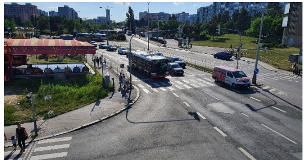
Obr. 9 Počátek vyhrazeného jízdního pruhu již v rámci řadicích pruhů (ul. Opatovská, Praha)
