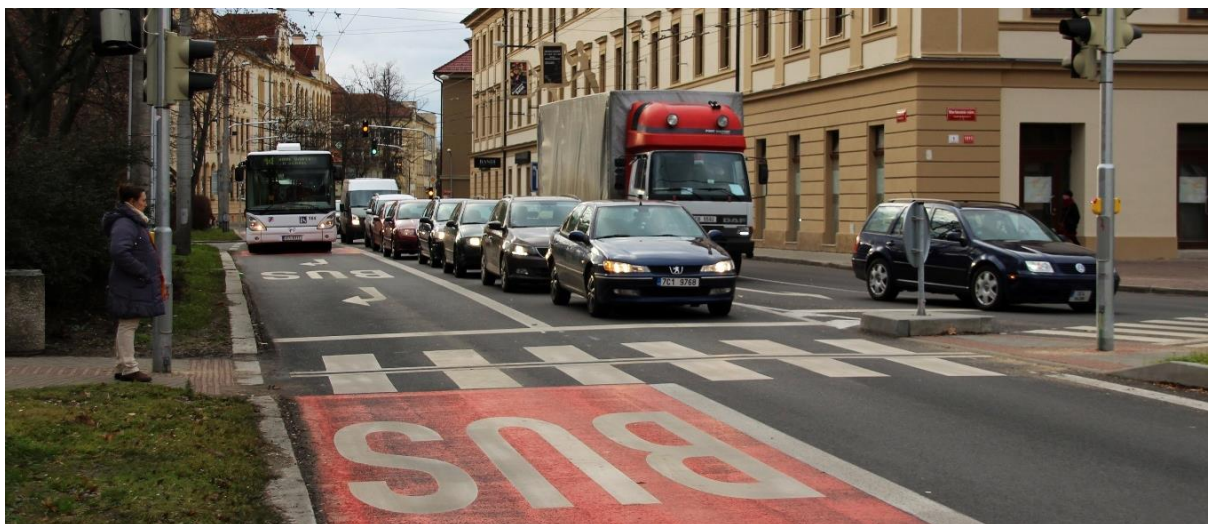
Obr. 1 Příklad preferenčního opatření k rychlému a plynulému průjezdu spojů veřejné dopravy křižovatkou (České Budějovice) [4]
