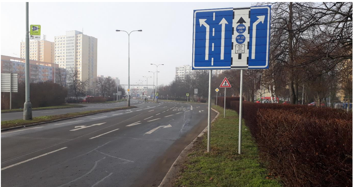
Obr. 20 Vznik vyhrazeného jízdního pruhu v souvislosti s neřízenou křižovatkou [4]
