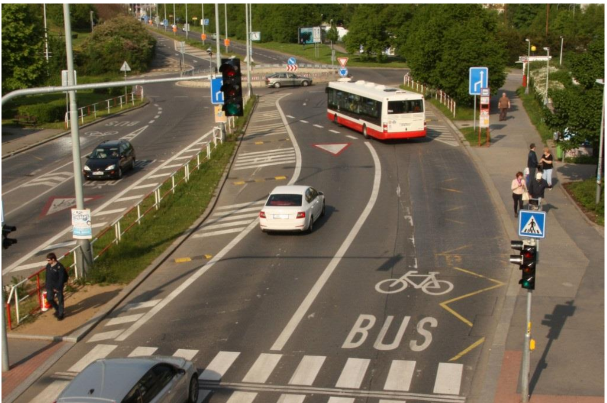
Obr. 11 Úprava přednosti v jízdě při výjezdu ze zastávky či vyhrazeného jízdního pruhu (Ul. Opatovská, Praha) [12]
