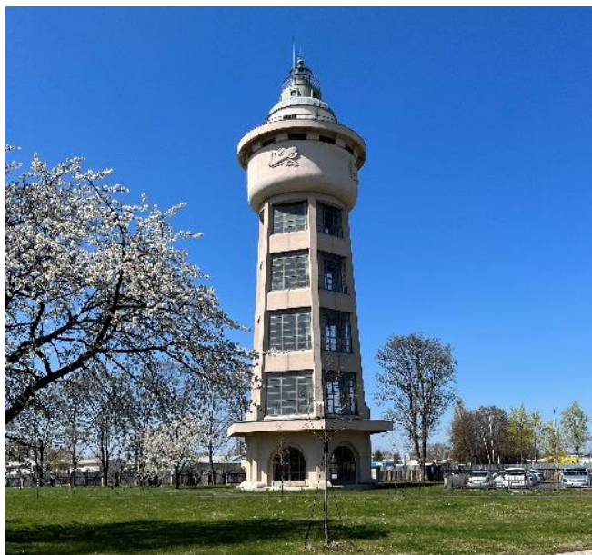
Obrázek 1 Vodárenská věž Kbely
