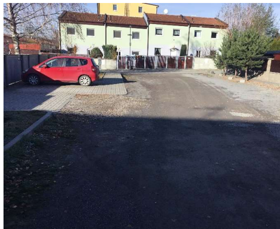
Obrázek 13 stavební úpravy rezidentů
