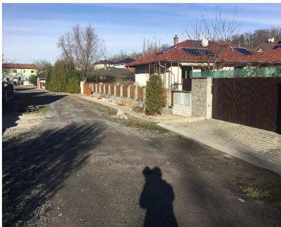
Obrázek 12 stavební úpravy rezidentů
