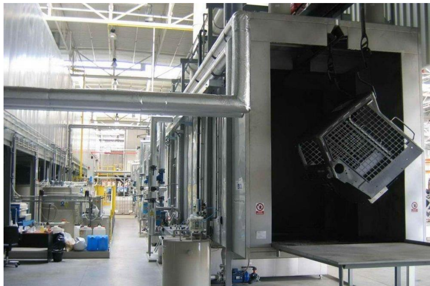
Obr. 16 - Vstup do tunelu chemických předúprav [33]
