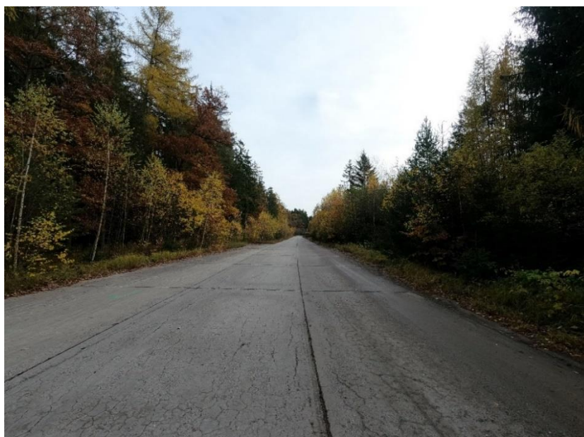
Obrázek 4 - Stávající stav (vlastní fotodokumentace)
