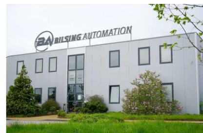
Obr. 3 Česká pobočka Bilsing Automation [3]
