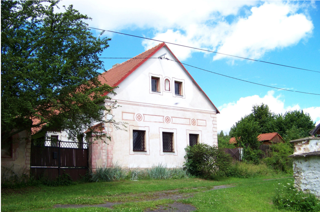
Obr. 2 - 1 Pohled východní na stávající objekt
