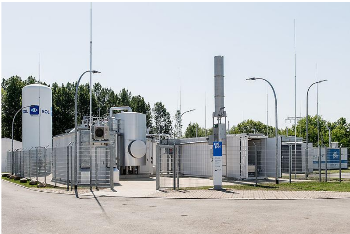
Obr. 12: Metanizační jednotka v demonstračním místě STORE&GO v obci Falkenhagen v Německu [47]
