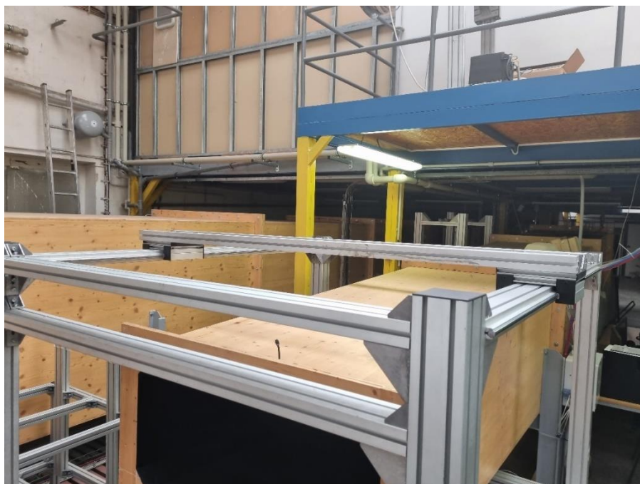
Obrázek 22: Průběh stavby manipulátoru
