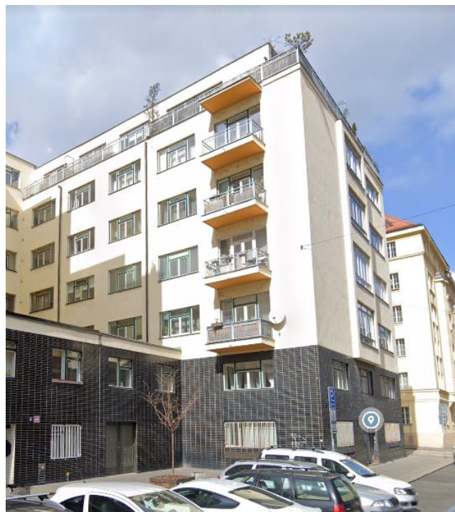
Obrázek 4: Bytový dům č. 2 (jižní a východní fasáda)
