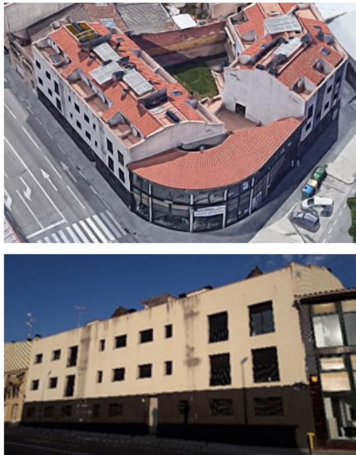
Obr. 6; Studovaná rezidenční budova
