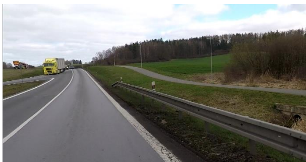
Obrázek 5 – Ocelové svodidlo umístěné v extravilánu.
