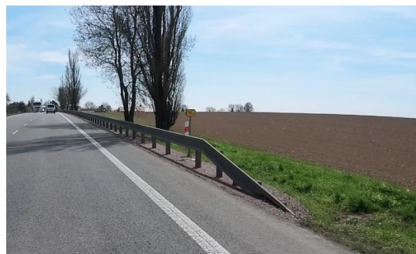
Obrázek 26 – Ukázka svodidla s krátkým výškovým náběhem (o délce 4 m) | TEN-T | I/35 | ID 38 511.
