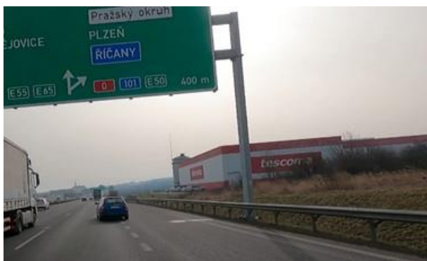
Obrázek 23 – Portálová konstrukce se nachází v pracovní šířce svodidla | TEN-T | D1 | ID 22 535. 1
