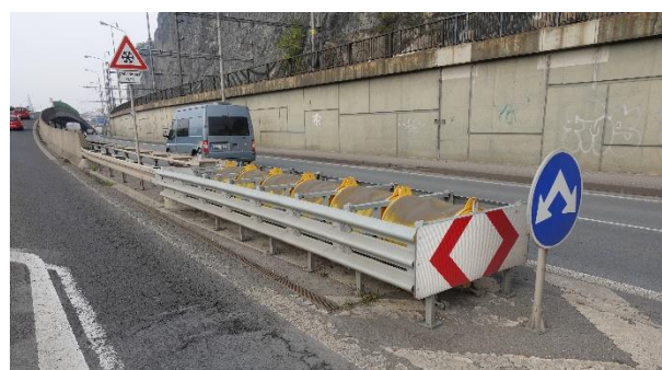
Obrázek 8 – Další ukázka tlumiče nárazu nacházejícího se v intravilánovém úseku.
