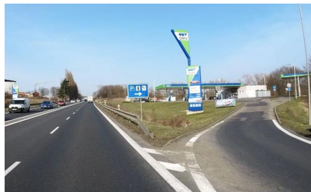
Obrázek 48 – Směrově nevychýlené svodidlo s krátkým výškovým náběhem | TEN-T | 1/3 | ID 10 351.
