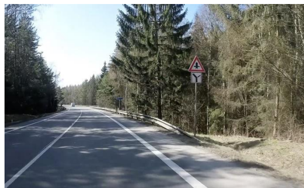
Obrázek 32 – Krátké ocelové svodidlo před pevnou překážkou (stromem) | TEN-T | I/35 | ID 35 163.
