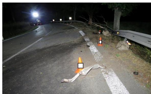
Obrázek 39 – Stromy v pracovní šířce svodidla ve směrovém oblouku. [40]
