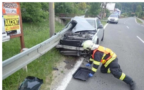
Obrázek 37 – Náraz do ocelového svodidla bez výškového náběhu. [40]
