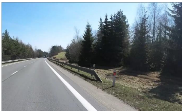
Obrázek 25 – Krátký výškový náběh ocelového svodidla o délce 2 m | TEN-T | I/35 | ID 13 013.
