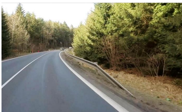
Obrázek 55 – Krátký výškový náběh ocelového svodidla na pravé straně PK | TEN-T | 1/3 | ID 22 202.
