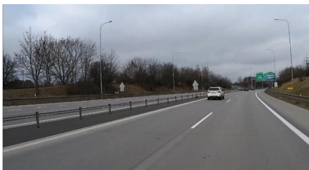
Obrázek 14 – Lanové svodidlo ve středním dělicím pásu (dále jen „SDP“) na dálnici D0.
