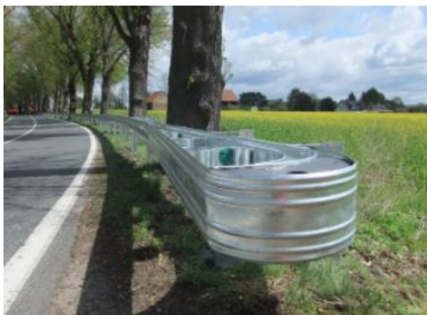
Obrázek 27 – Alternativní ukončení svodidla (terminál) Primus P2. [35]
