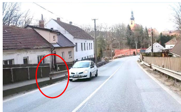
Obrázek 56 – Absence výškového náběhu ocelového svodidla na levé straně PK | BI JCK | 1/19 | ID 7 373.
