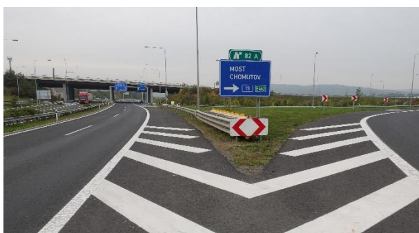
Obrázek 7 – Tlumič nárazu v místě dopravního ostrůvku.
