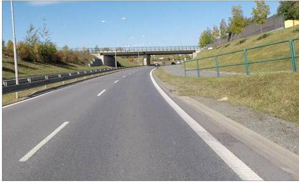
Obrázek 9 – Zábradlí oddělující PK a chodník.
