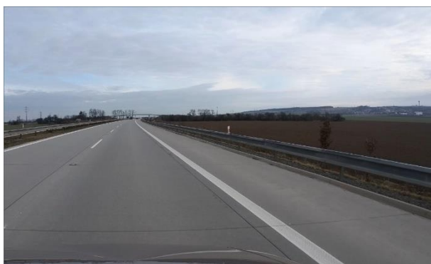
Obrázek 12 – Ocelové svodidlo typu NH4 na dálnici D0.
