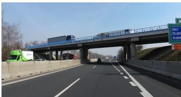
Obrázek 16 – Betonová svodidla po obou stranách dálnice D10.
