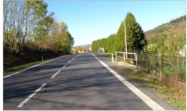
Obrázek 10 – Zábradlí ochraňující hlubinu před pádem chodce.
