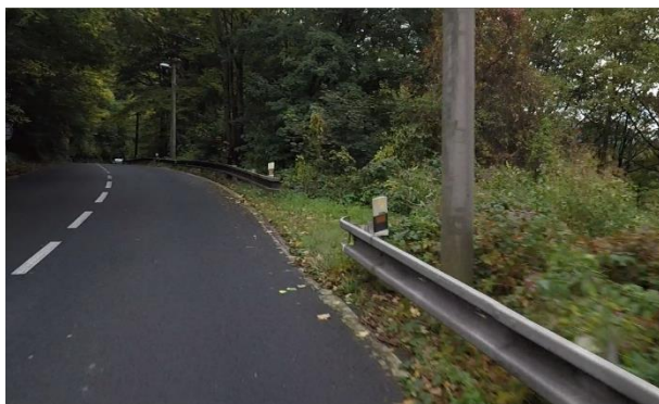
Obrázek 47 – Směrově nevychýlené svodidlo bez výškového náběhu | BI UK | 1/62 | ID 9 126.
