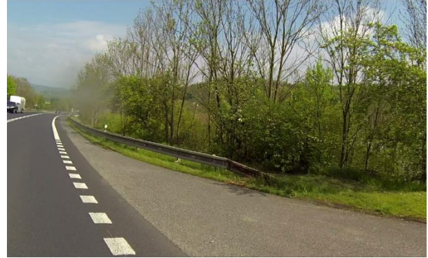
Obrázek 50 – Částečně směrově vychýlené svodidlo s krátkým výškovým náběhem | BI UK | I/15 | ID 1 500.
