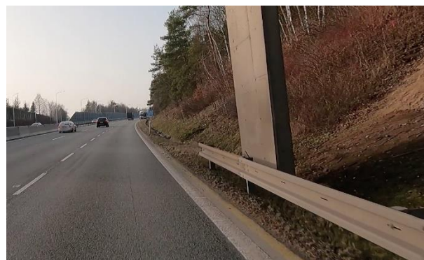
Obrázek 24 – Mostní pilíř nacházející se v pracovní šířce ocelového svodidla | TEN-T | D1 | ID 22 238.
