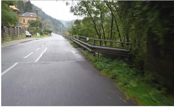
Obrázek 49 – Částečně směrově vychýlené svodidlo bez výškového náběhu | BI UK | I/62 | ID 9 021.
