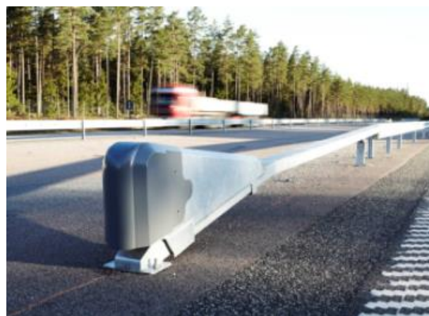
Obrázek 28 – Alternativa k výškovému náběhu s možností absorbování energie kolidujících vozidel SafeEnd. [35]
