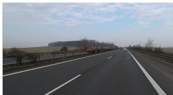
Obrázek 15 – Lanové svodidlo v SDP na dálnici D8.
