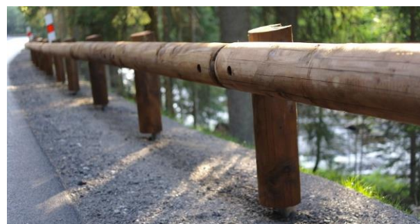
Obrázek 18 – Detail provedení dřevoocelového svodidla. [26]
