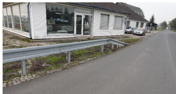
Obrázek 6 – Ocelové svodidlo v intravilánu.
