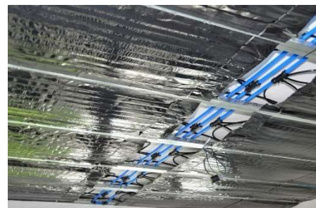
Obr. 3 – Chladicí registry od firmy FV – Plast [1]
