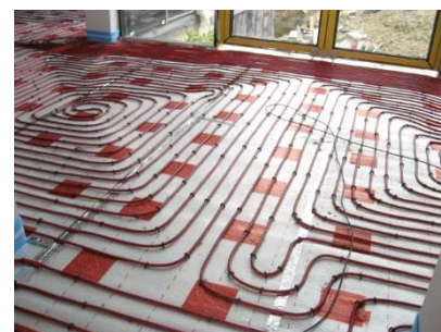
Obr. 18 – Přichytkový systém zvaný též tacker [16]
