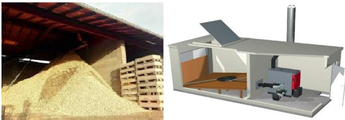
Obrázek č. 13 Venkovní zásobník dřevní štěpky pod krytem (vlevo) a model denního zásobníku se šnekovým dopravníkem (vpravo) [14], [8]
